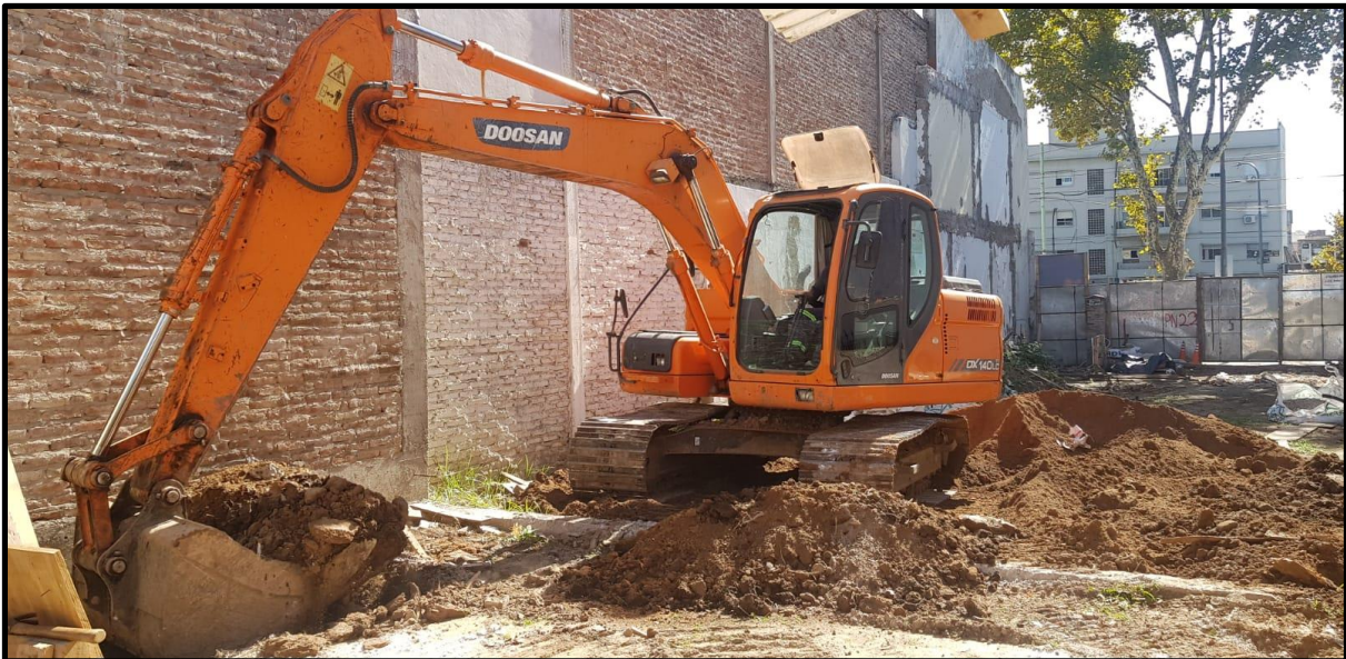
NOTA: Trabajo de apertura de base de máquina retroexcavadora
