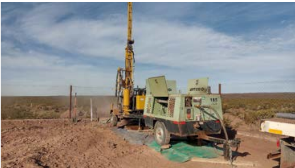
Equipo de perforación en posición
