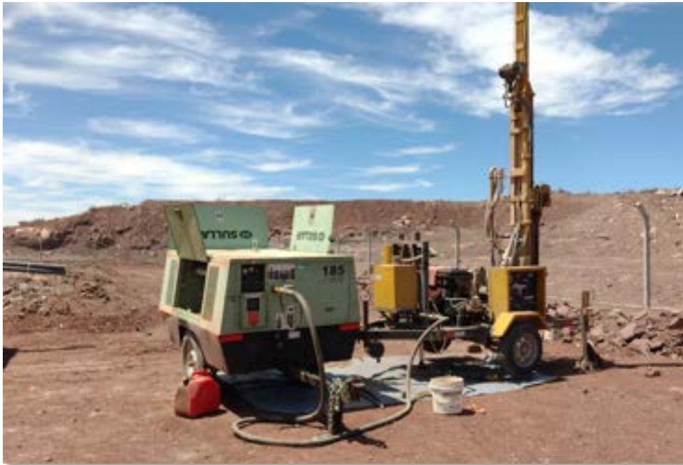
Equipos nivelados listo para iniciar una perforación
