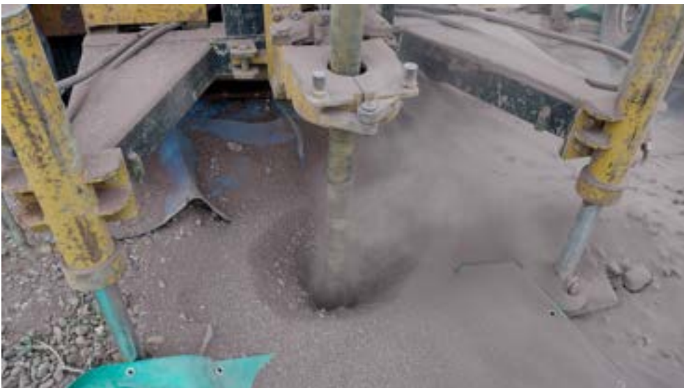
Boca de pozo, sector en el que se ubica el operario Boca de Pozo
