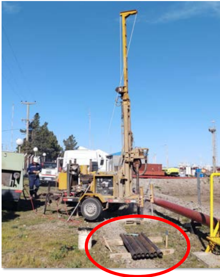
Barras estibadas en el equipo de perforación
