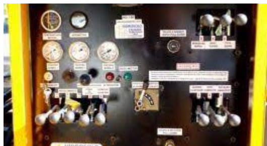
Mandos del equipo de perforación.
