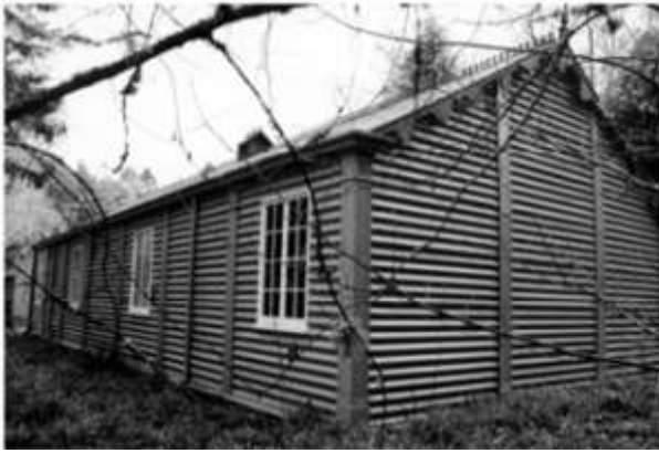
Construcciones de chapa galvanizada según el método Morewood & Rogers (Publicación de 1894)
