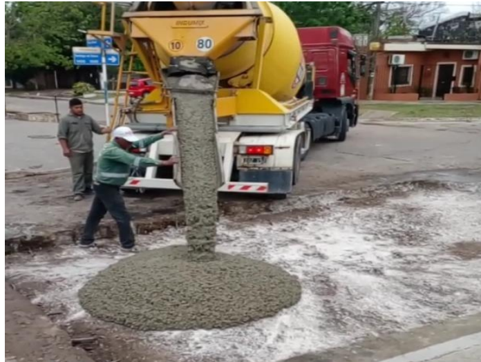
Imagen 5: Colocación de Hormigón
