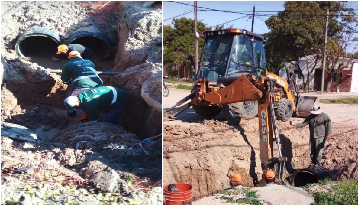
Imagen 3: Colocación de caños de desagüe
