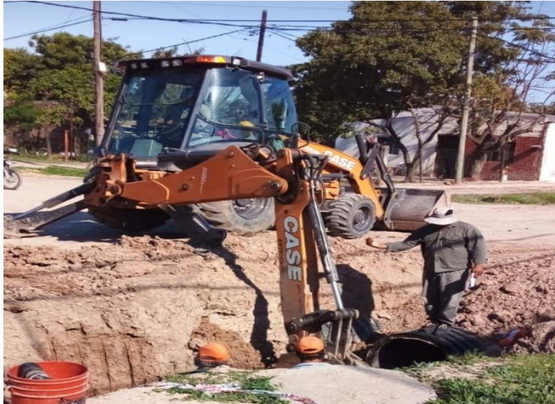
Imagen 1: retroexcavadora sacando la tierra
