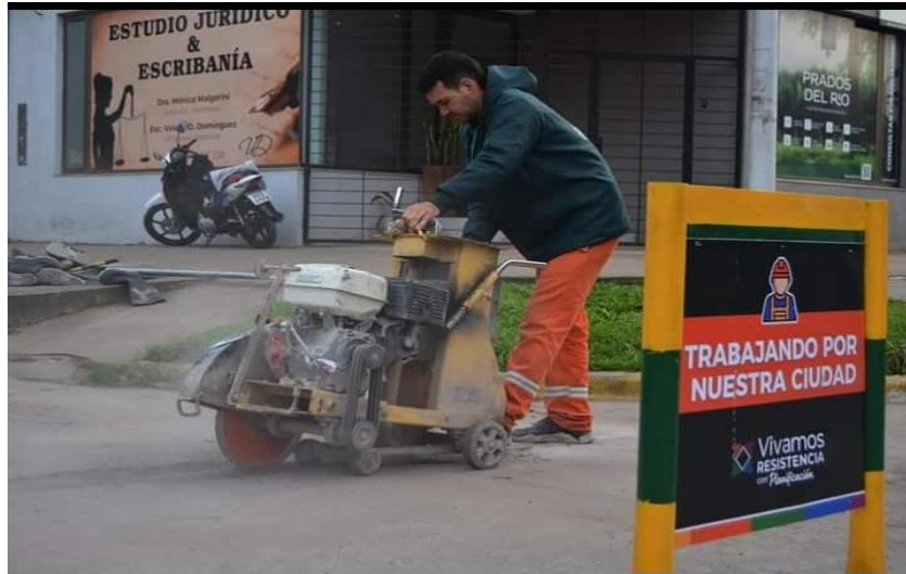
Imagen 6: Máquina cortadora de pavimento diamantada
