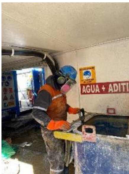
Figura N° 9: Operario preparando lodo de perforación, [Fuente: Griffith 2023]
