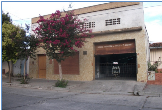
Figura N° 10. Vista de acceso por calle Ibazeta
