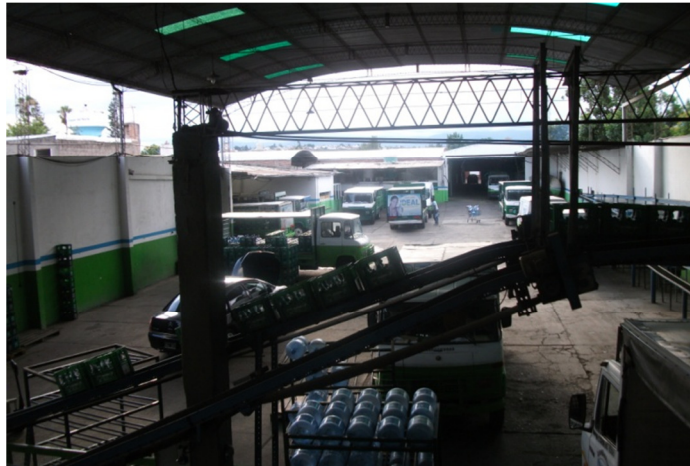
Figura N° 5. Vista de Playa Semicubierta
