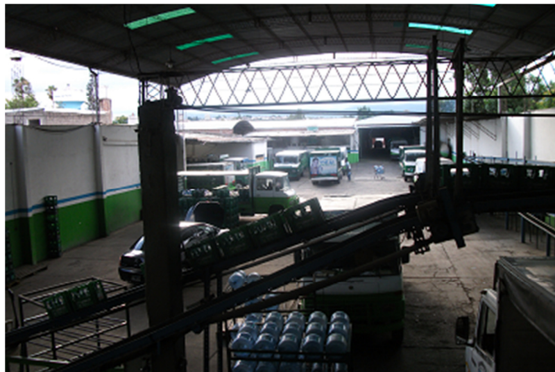
Figura N° 26 –Parte alta de cinta transportadora
