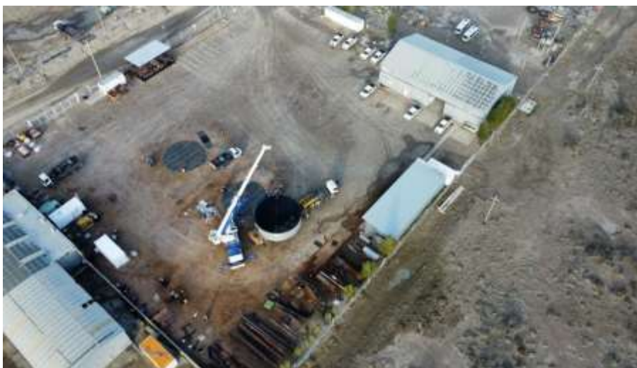
(Base Operativa de Manpetrol S.A. ubicada en Valle Hermoso)
