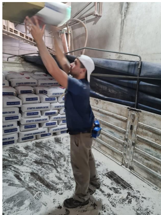
Fotografía 9: Operario tomando la carga
