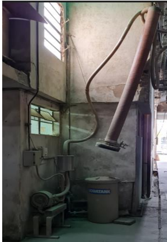
Fotografía 13: Imagen del sistema de carga por vacío
