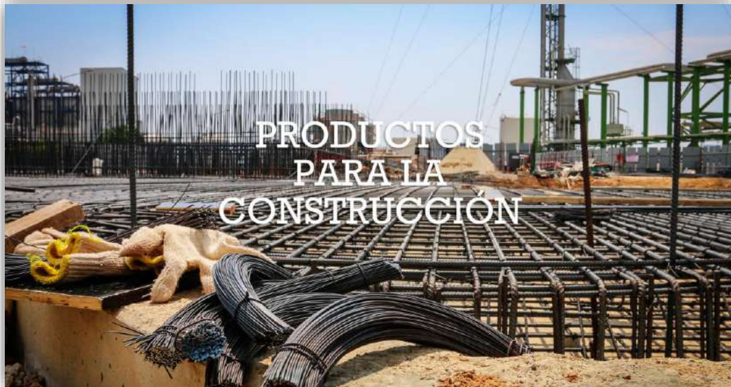
3 Área de construcción
