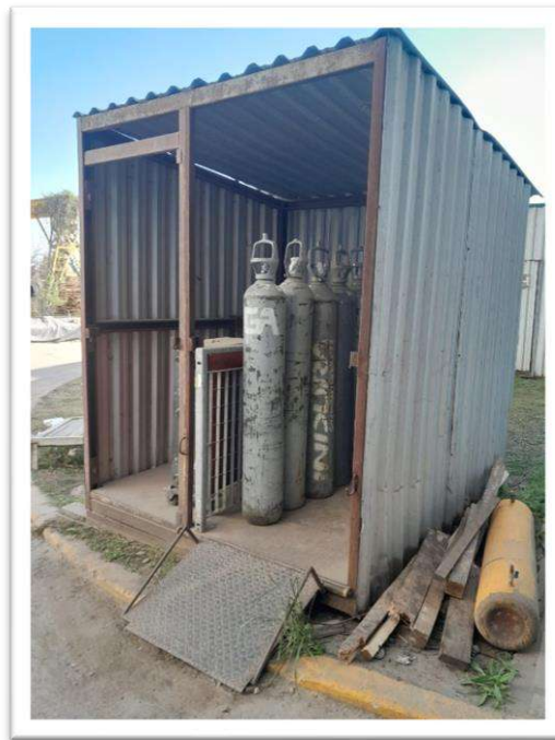
27 Riesgo de explosión
