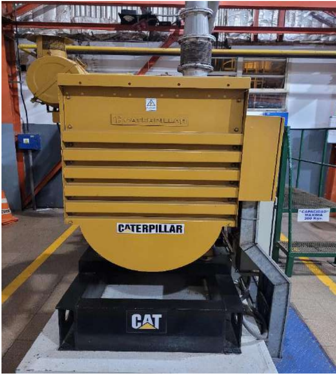
MOTO-GENERADOR MG1- CATERPILLAR 3412
