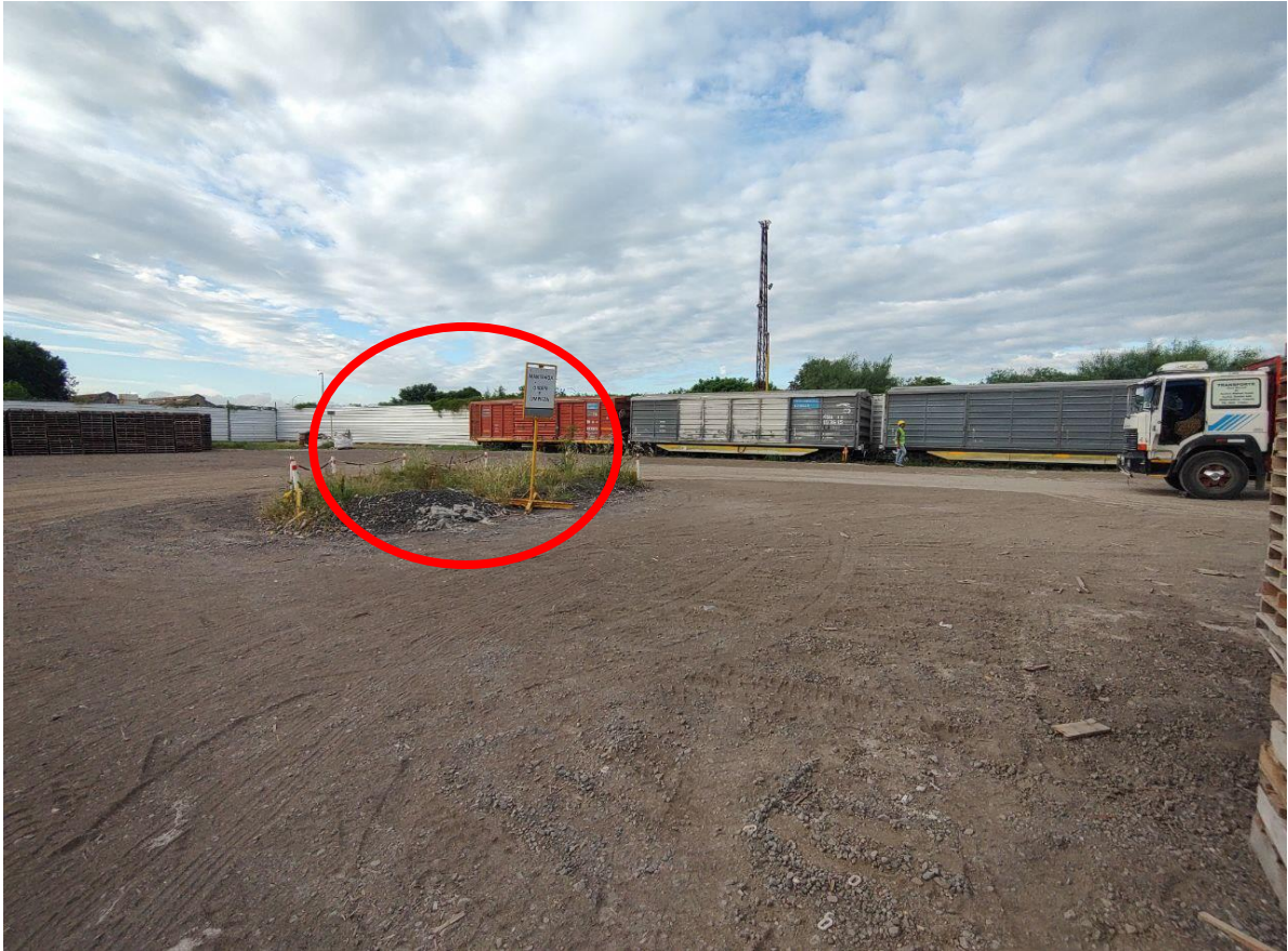
Fotografía N°13: Sector "Playón de Pallets." Acondicionar para ser un lugar seguro para choferes.
