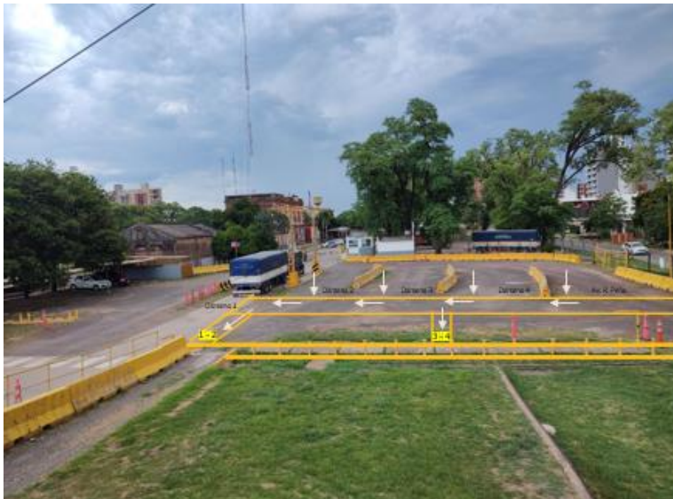
Fotografía N°12: Zona enlonado. Falta de delimitación senda peatonal.
