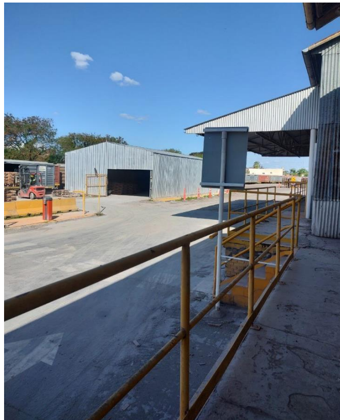
Fotografía N°1: Calle principal de descarga/carga de materiales/pallets.
