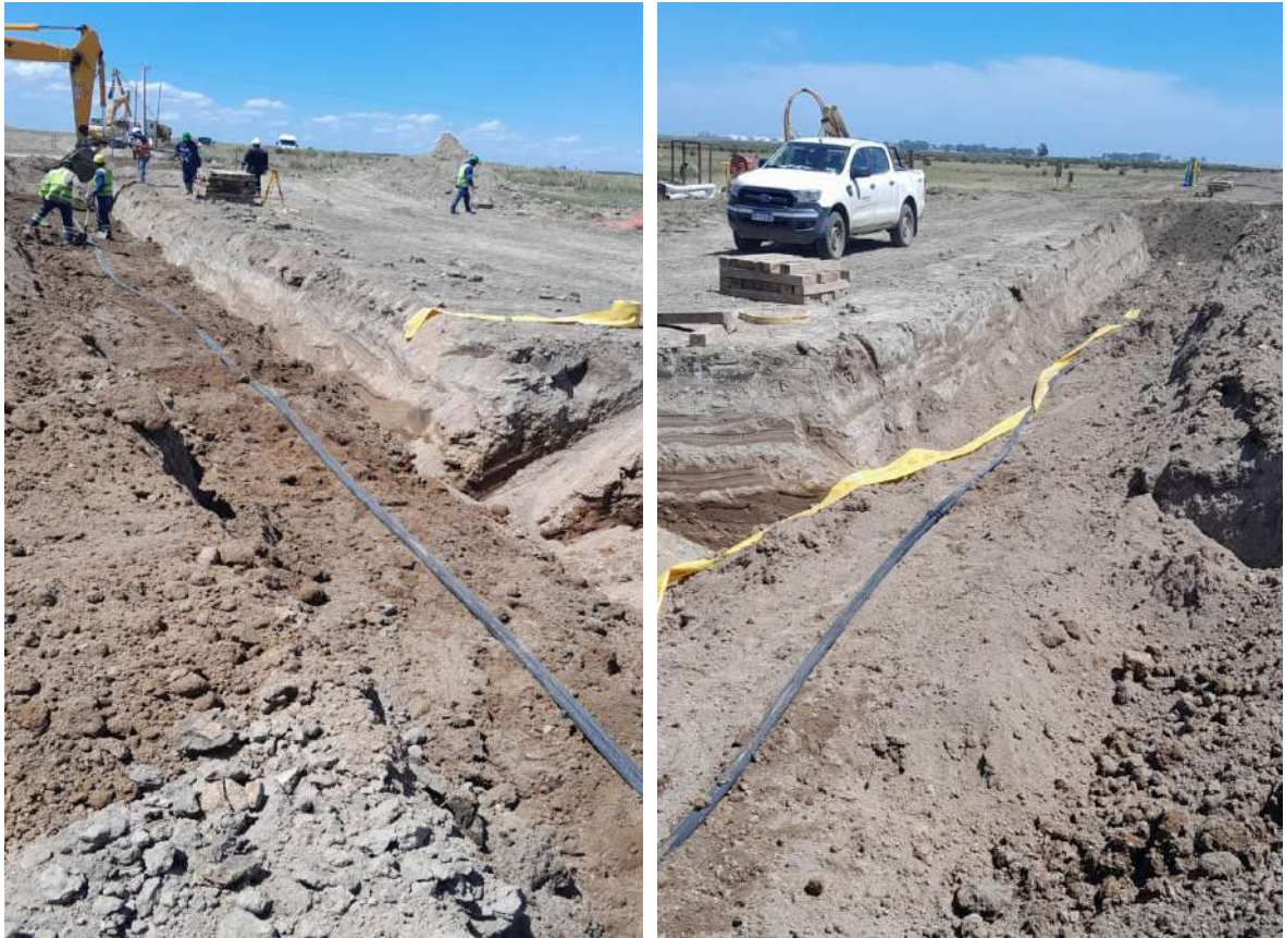
Zanqueo y Tapada , Tareas de pre tapado colocación de bitubo
