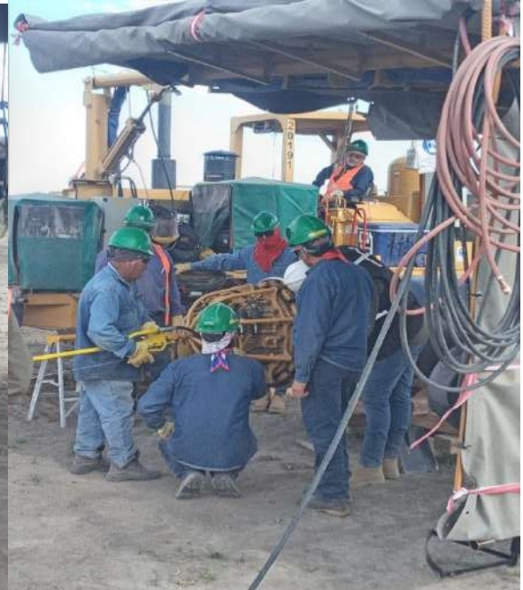
Acoplamiento, falla en los pistones neumáticos
