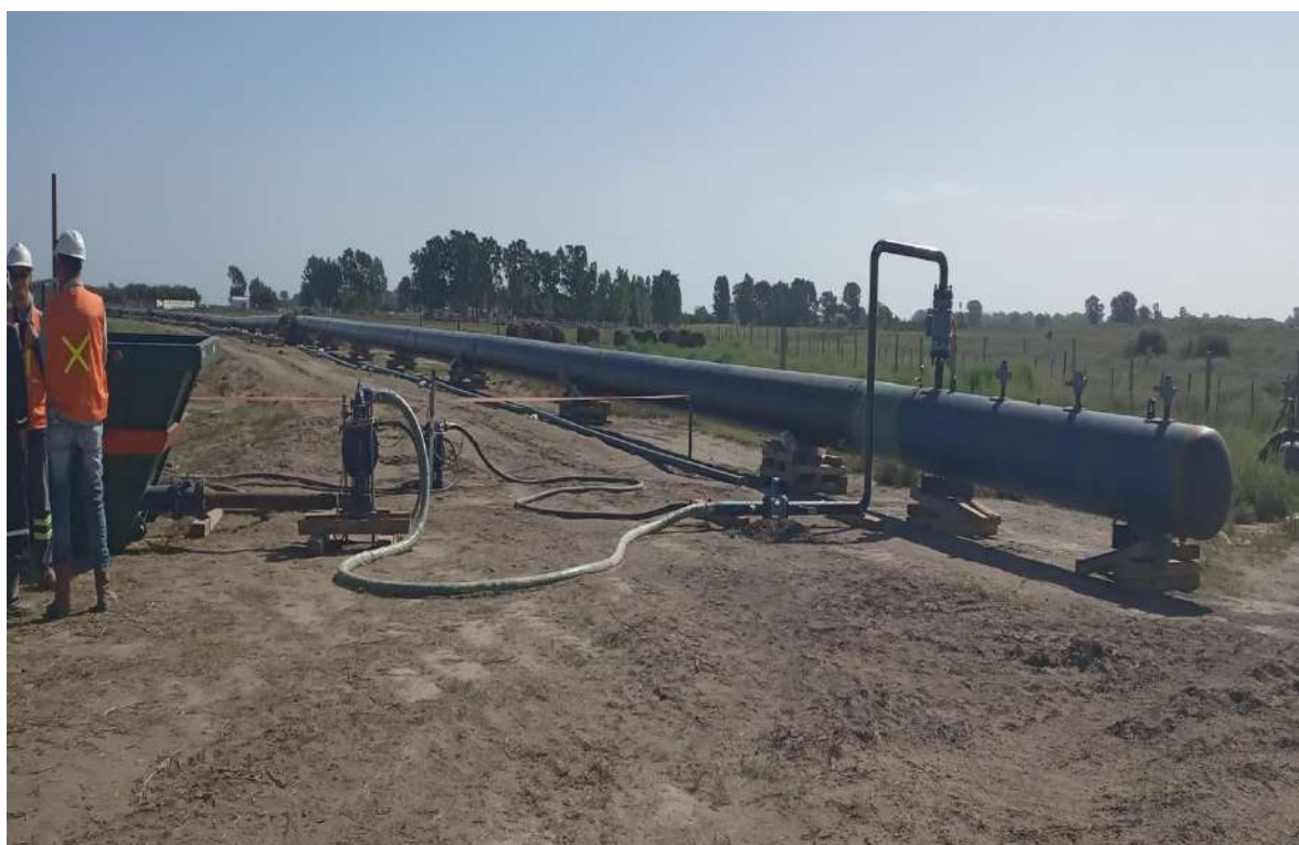
Prueba Hidráulica, Tramo de 800 metros de largo en la línea.
