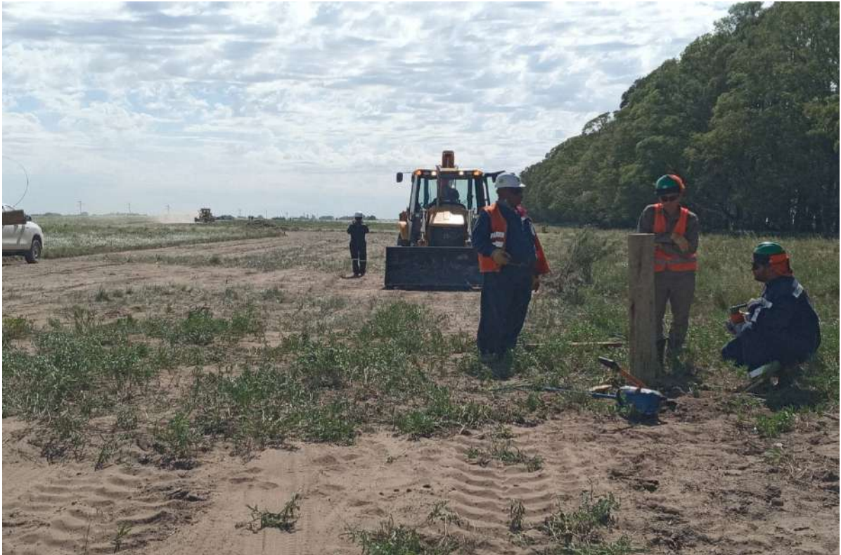
Apertura de Pista, Construcción de tranquera, Zona Salitral
