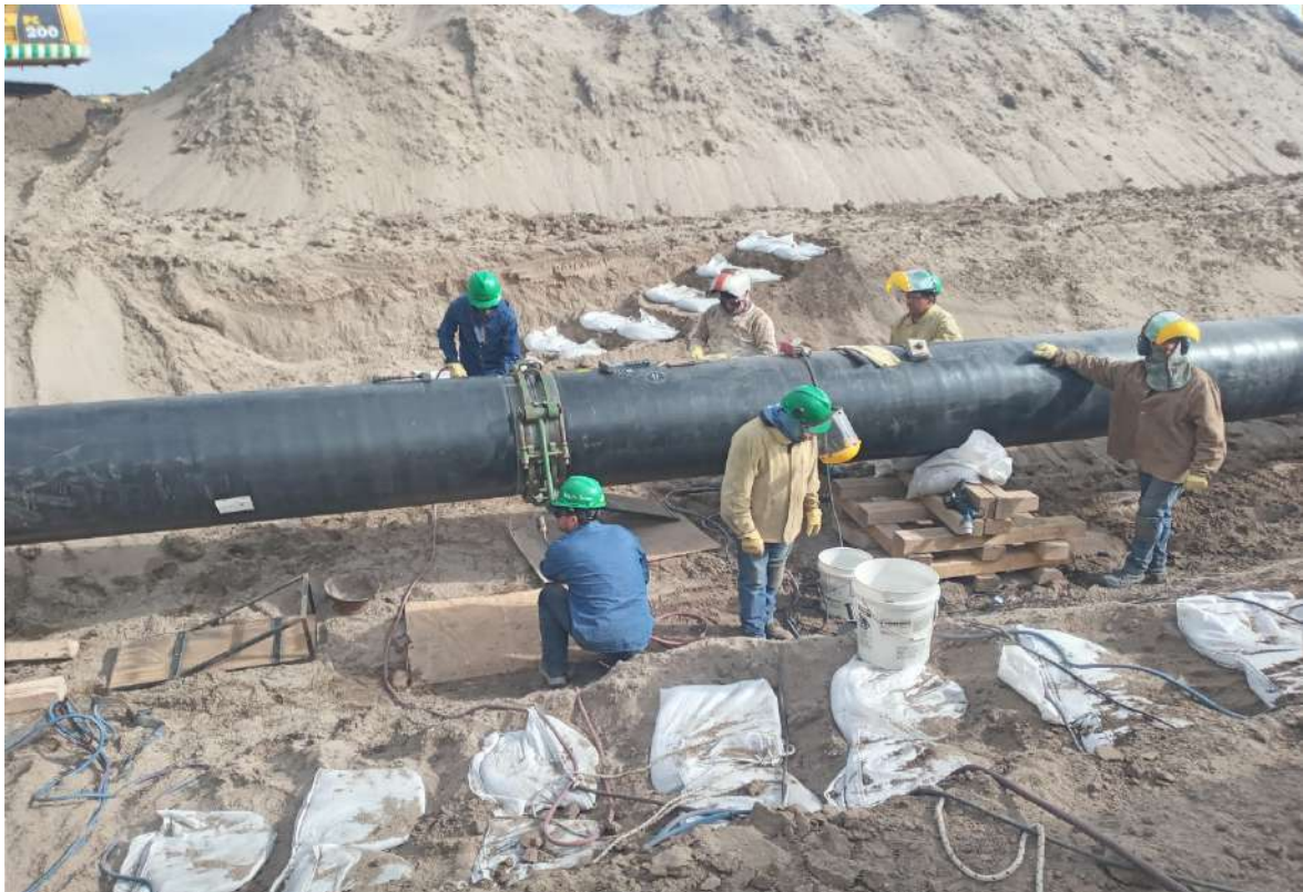
Empalme , Zona del obrador salida de interferencia camino estratégico.
