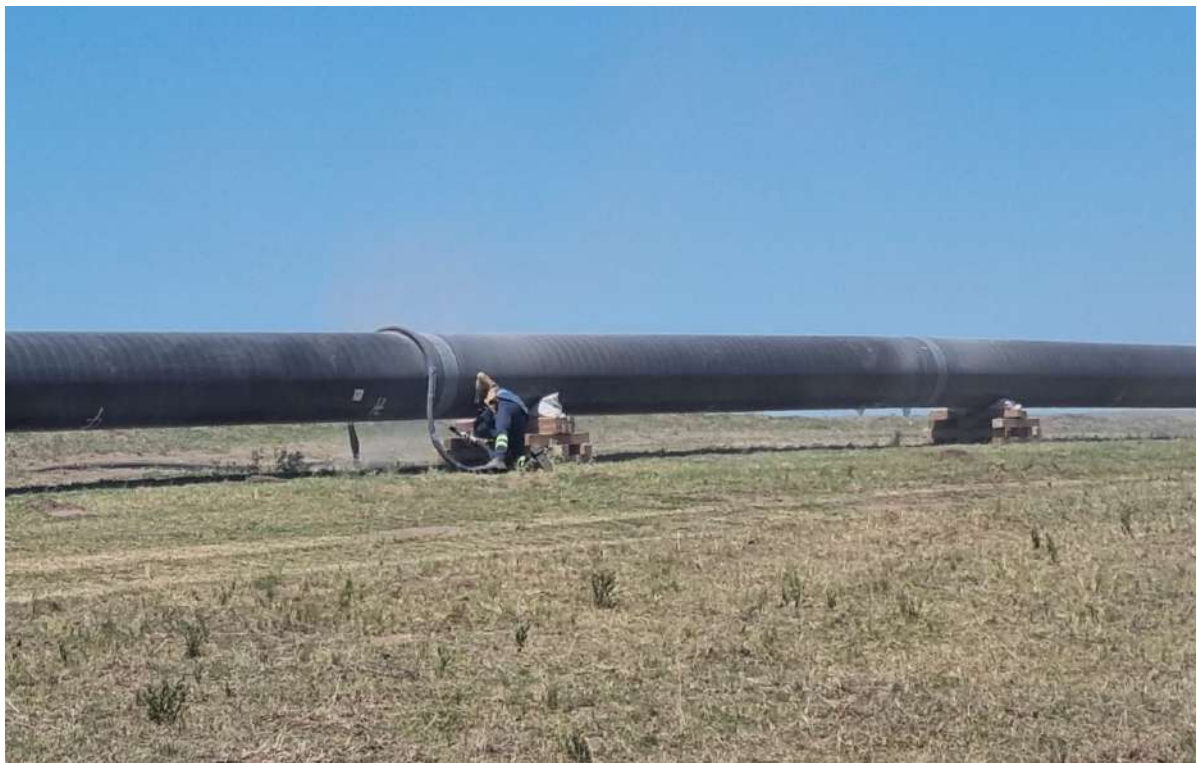
Arenado y Revestimiento, trabajos de arenado.
