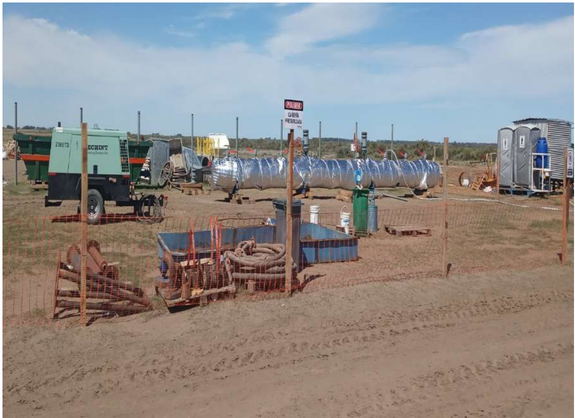
Obrador, Prueba Hidráulica de los cabezales y válvulas
