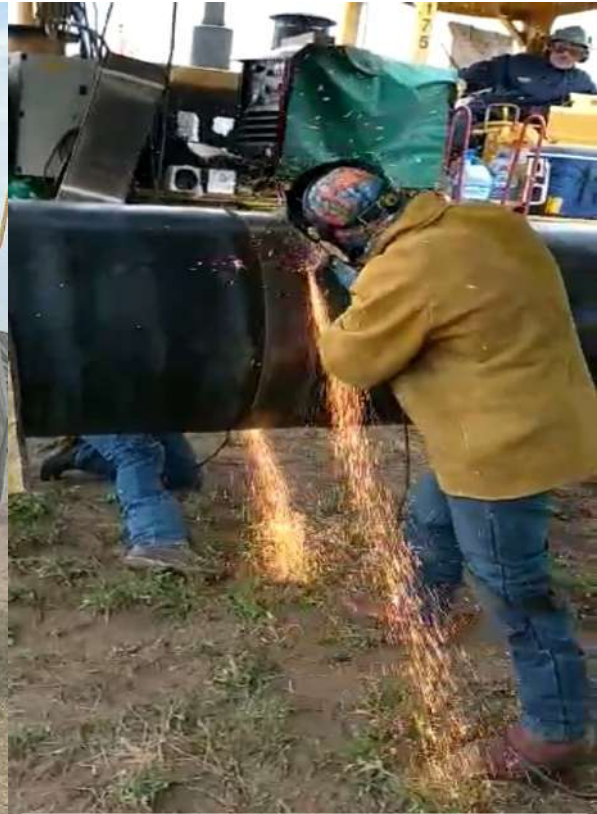
Soldadura en la Línea, tareas de amolado sobre el caño.
