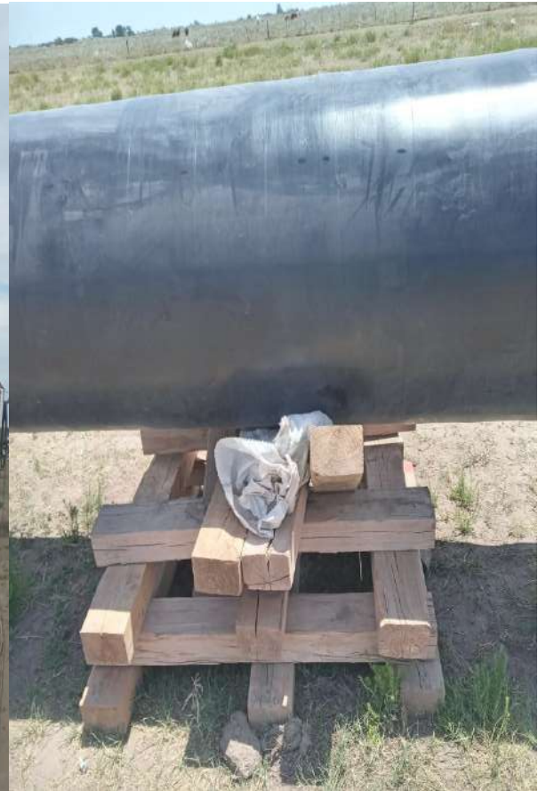
Acoplamiento, colocación de tacos de madera
