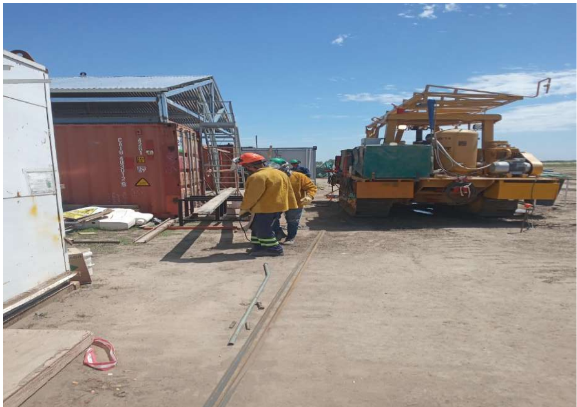
Soldando estructura metálica en el obrador
