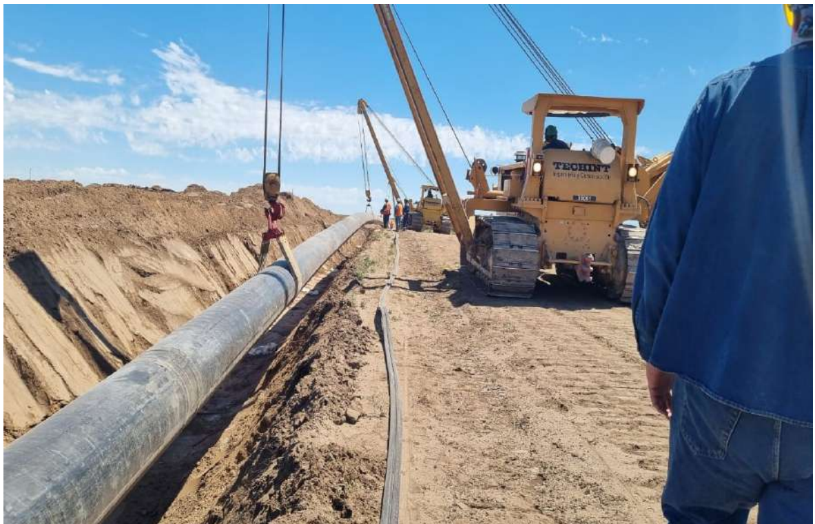
Bajada de Tubos, en PK 7.585+ de 800 metros
