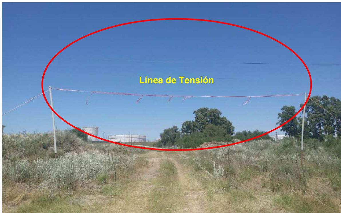
Apertura de Pista, Identificación de Línea de Tensión Zona Oiltanking
