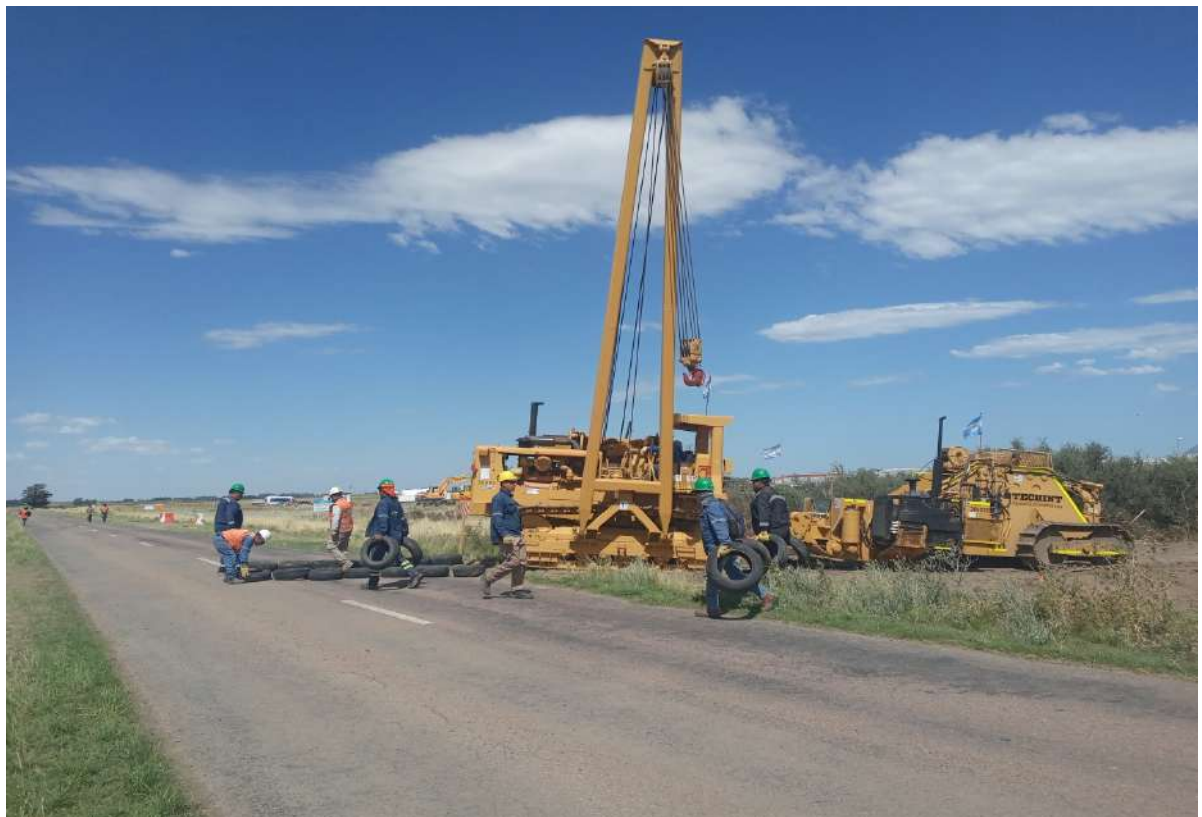
Curvado, Maniobra de Cruce Ruta S/N Camino Base Baterías
