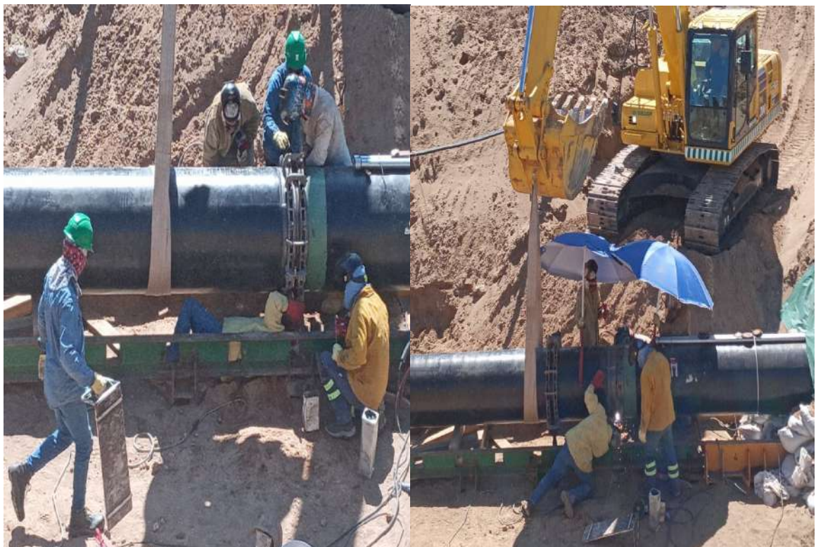
Cruce especial, Tareas de soldadura Ruta Nacional 249.
