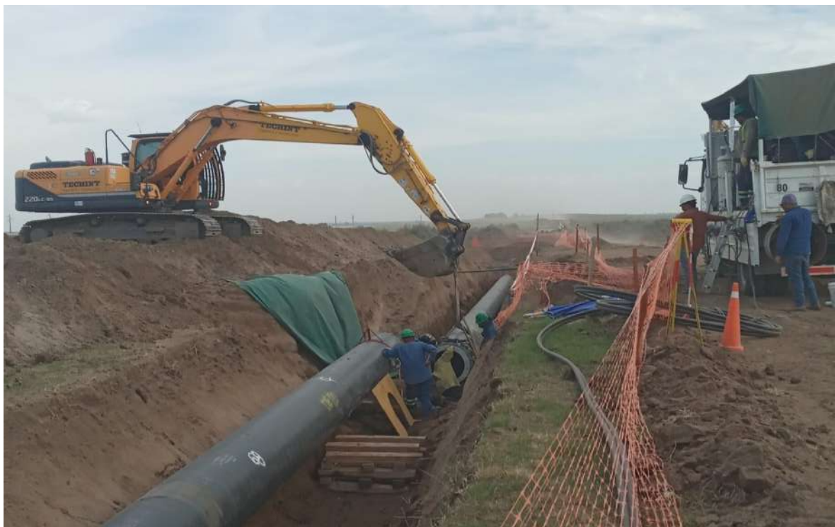
Empalme , Maniobra de acople en PK 1+500.
