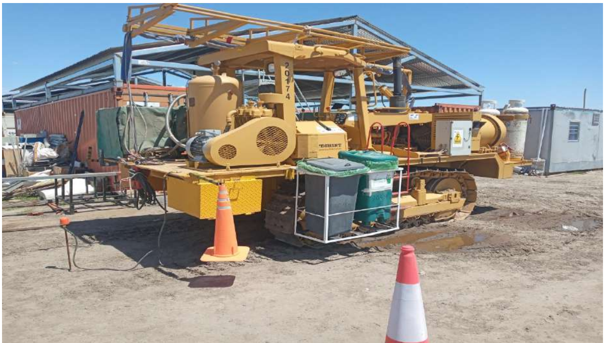
Pipe Wedler, en obrador
