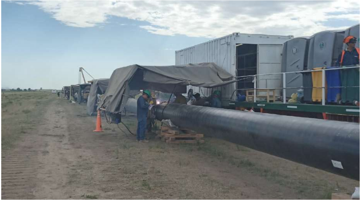
Soldadura en la Línea, finalización de la soldadura
