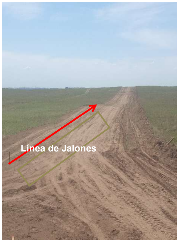
Demarcación de Jalones
