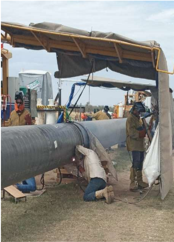
Soldadura en la Línea, trabajo de soldadores.
