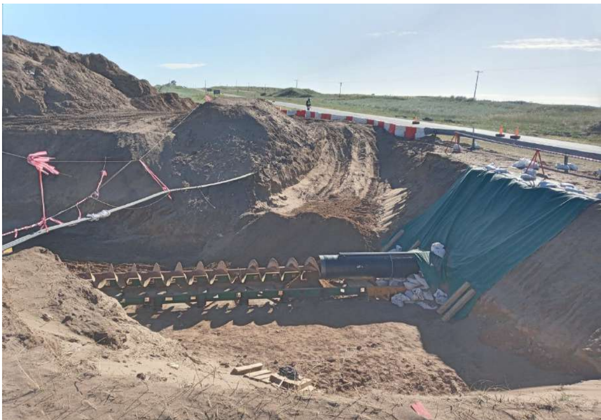
Cruce especial, Ruta Nacional 249 (inserción de tubo de 12 mts. de largo).
