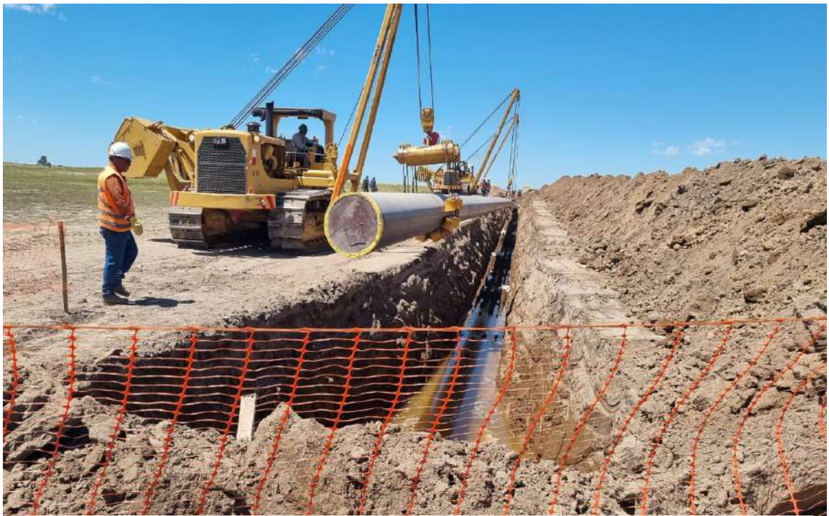
Bajada de Tubos; maniobra de bajada de tubos Coronel Rosales .
