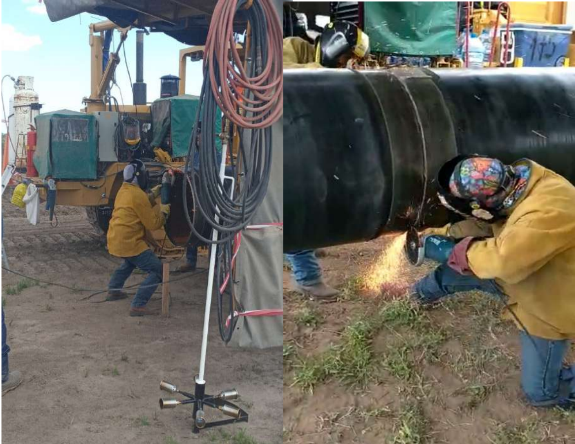
Amoladores, Tarea de Amolado y Cepillado
