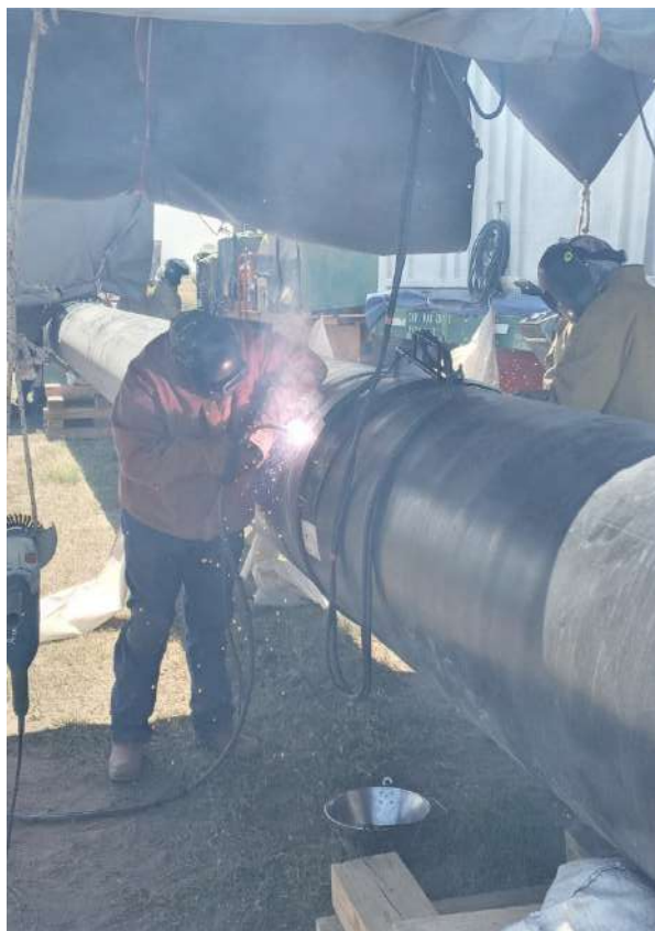
Soldadura en la Línea, soldadora stick con aporte de alambre 2.5mm.
