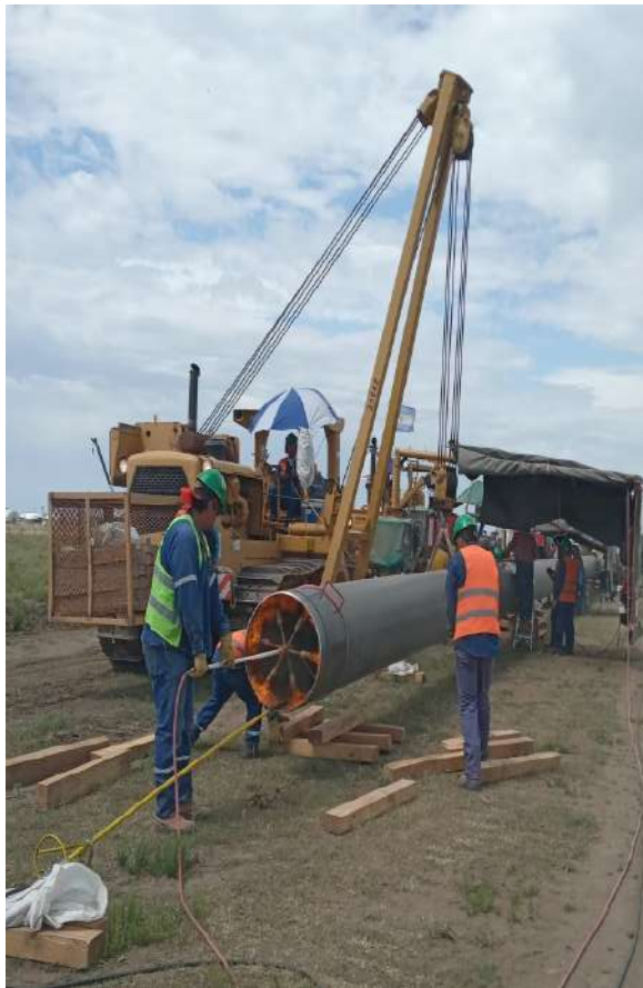
Acoplamiento, calentamiento de uno de los extremos del tubo
