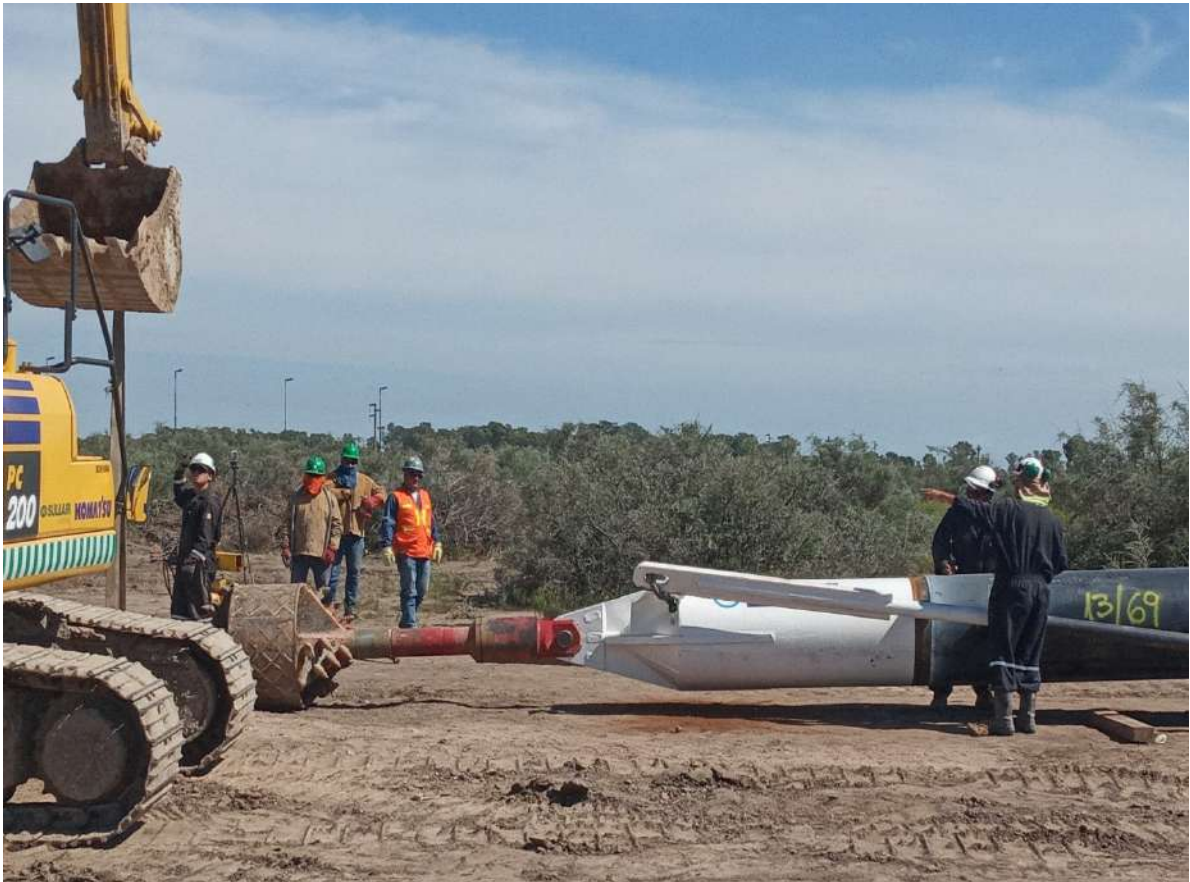
Teledirigido , maniobra de acople de trepano y caño bitubo.
