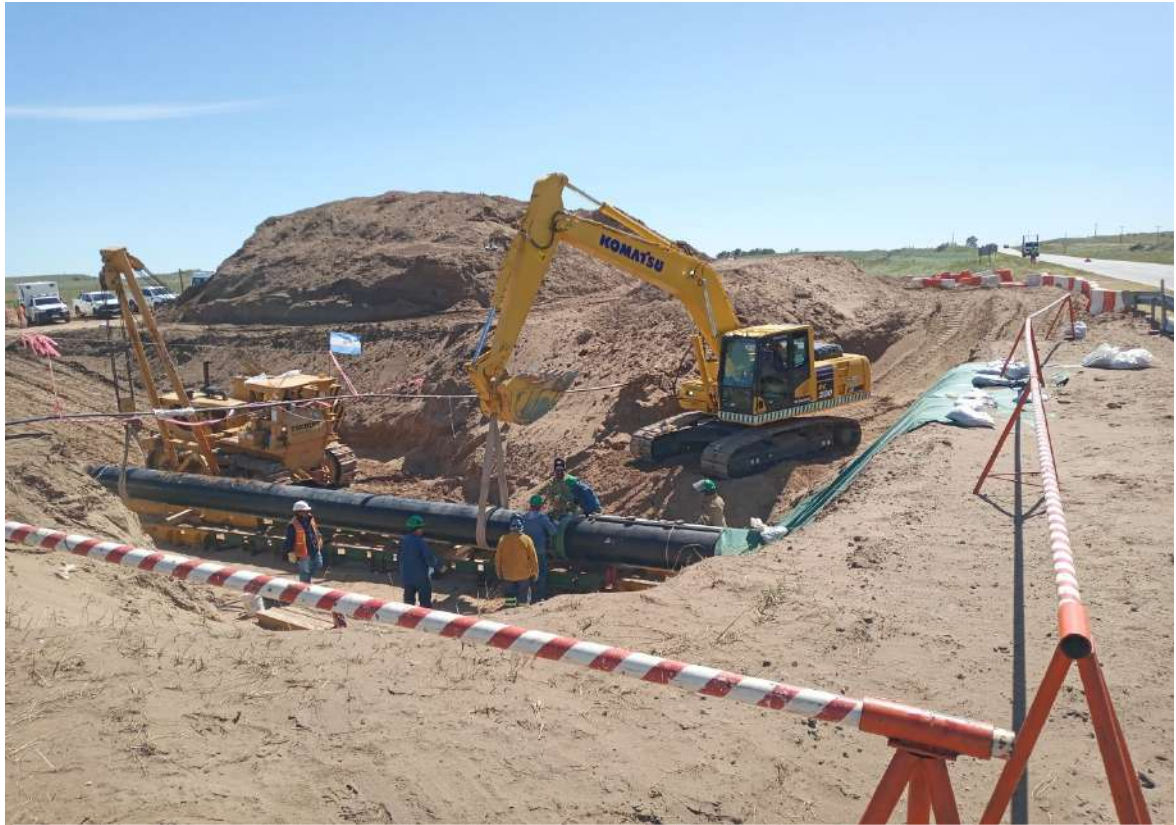
Cruce especial, Maniobra de acople segundo tramo de tubo.
