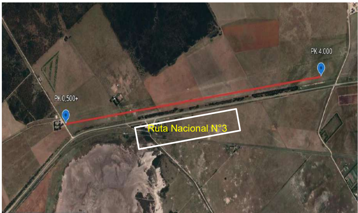
Obra de 4 Kilómetros zona Salitral , Provincia de Buenos Aires
