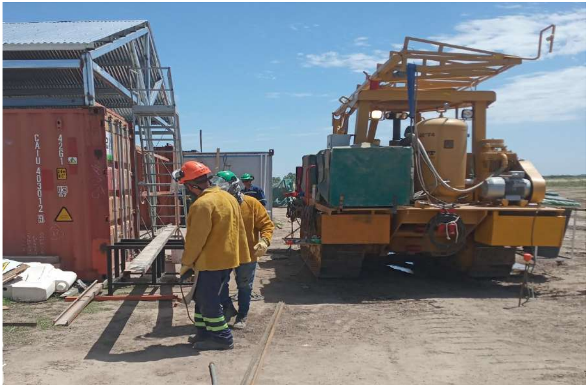
Obrador, tareas de herrería
