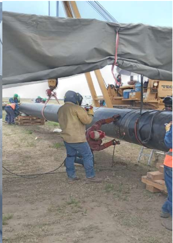
Soldadura en la Línea, soldadura eléctrica con electrodo E90/10E
