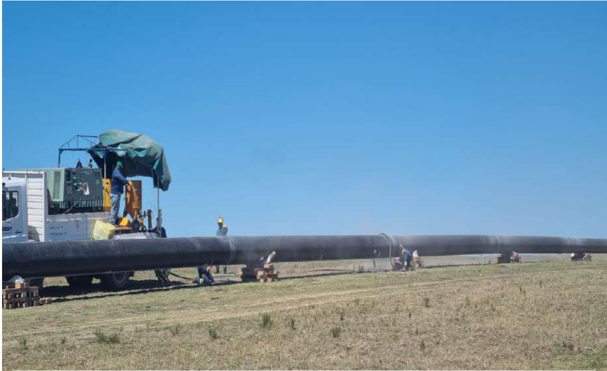
Arenado y Revestimiento, cuadrilla de arenado y revestimiento en la línea.
