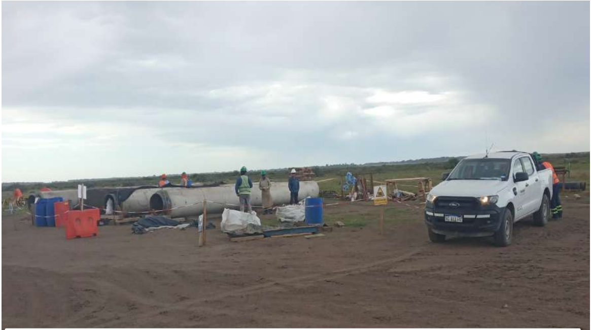
Obrador; trabajos de obra civil caños revestido con hormigón
