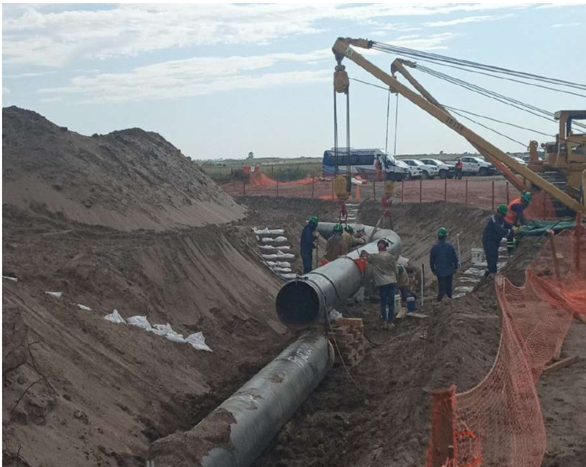
Empalme , Zona del Obrador, Ruta estratégica Base Baterías.
