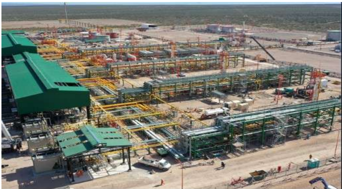
Finalización Fase 4 Fortín de Piedra Añelo Neuquén
