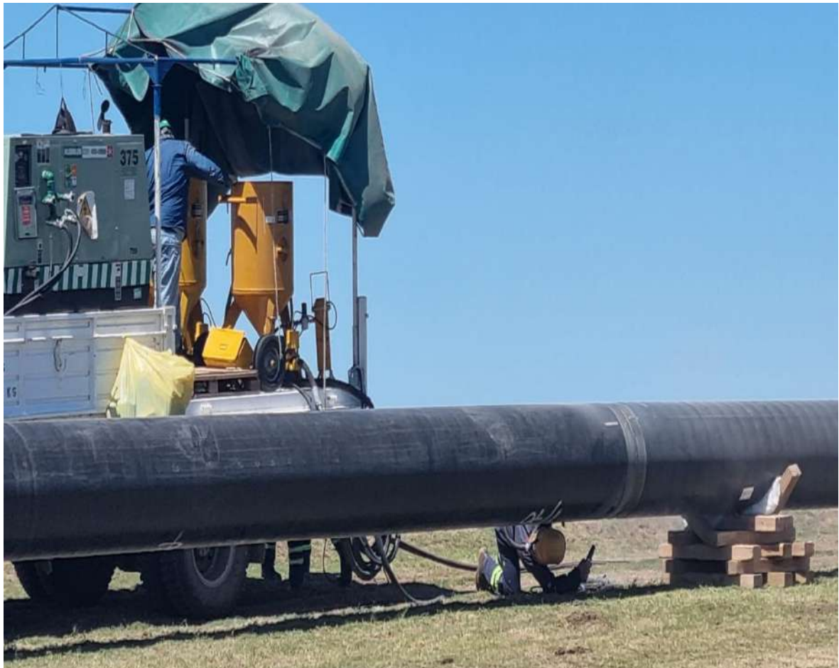
Arenado y Revestimiento, operario realizando tareas de arenado.
