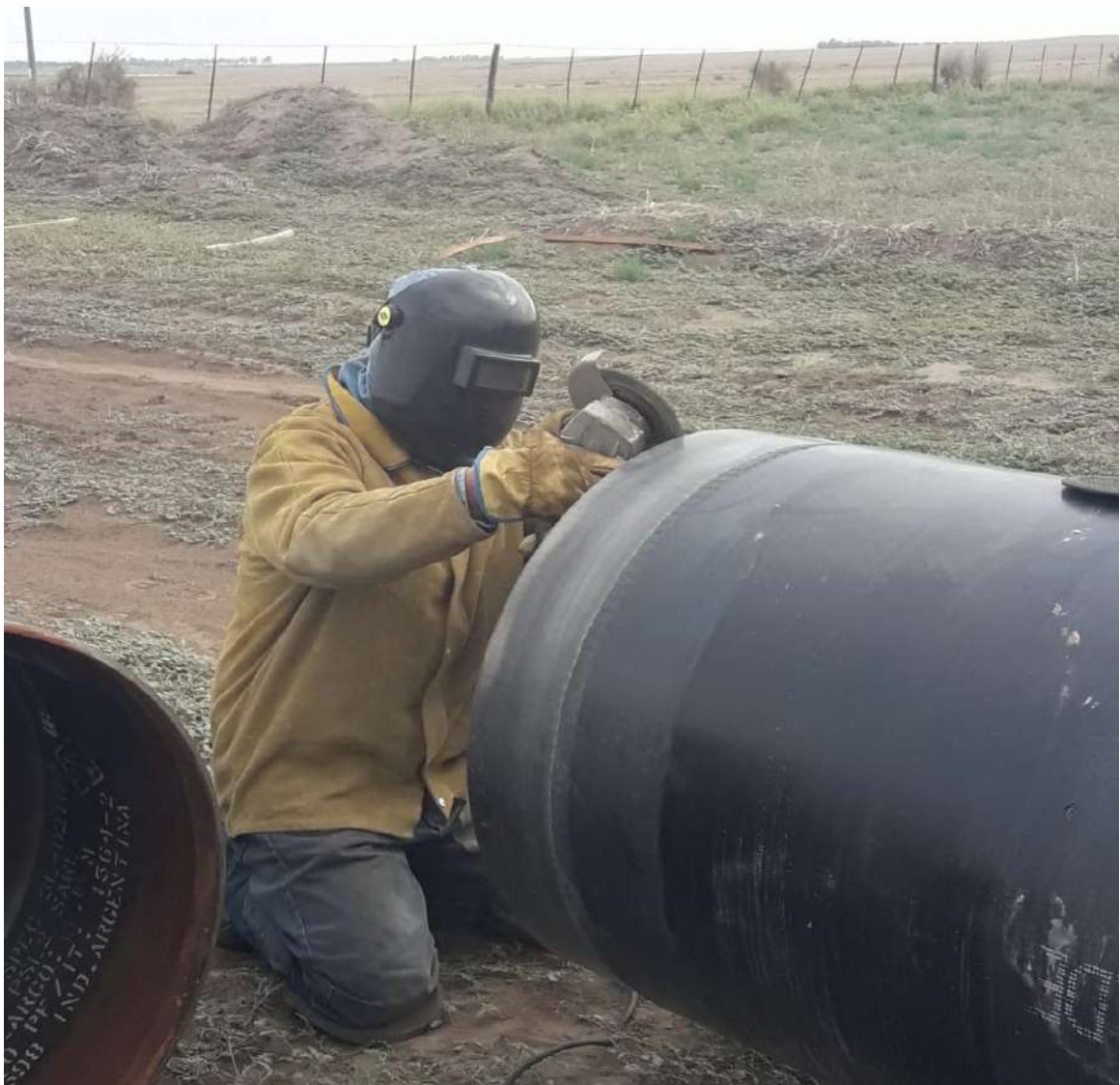
Amolado y Biselado, limpieza de tubos de 30" con el cepillo de acero
