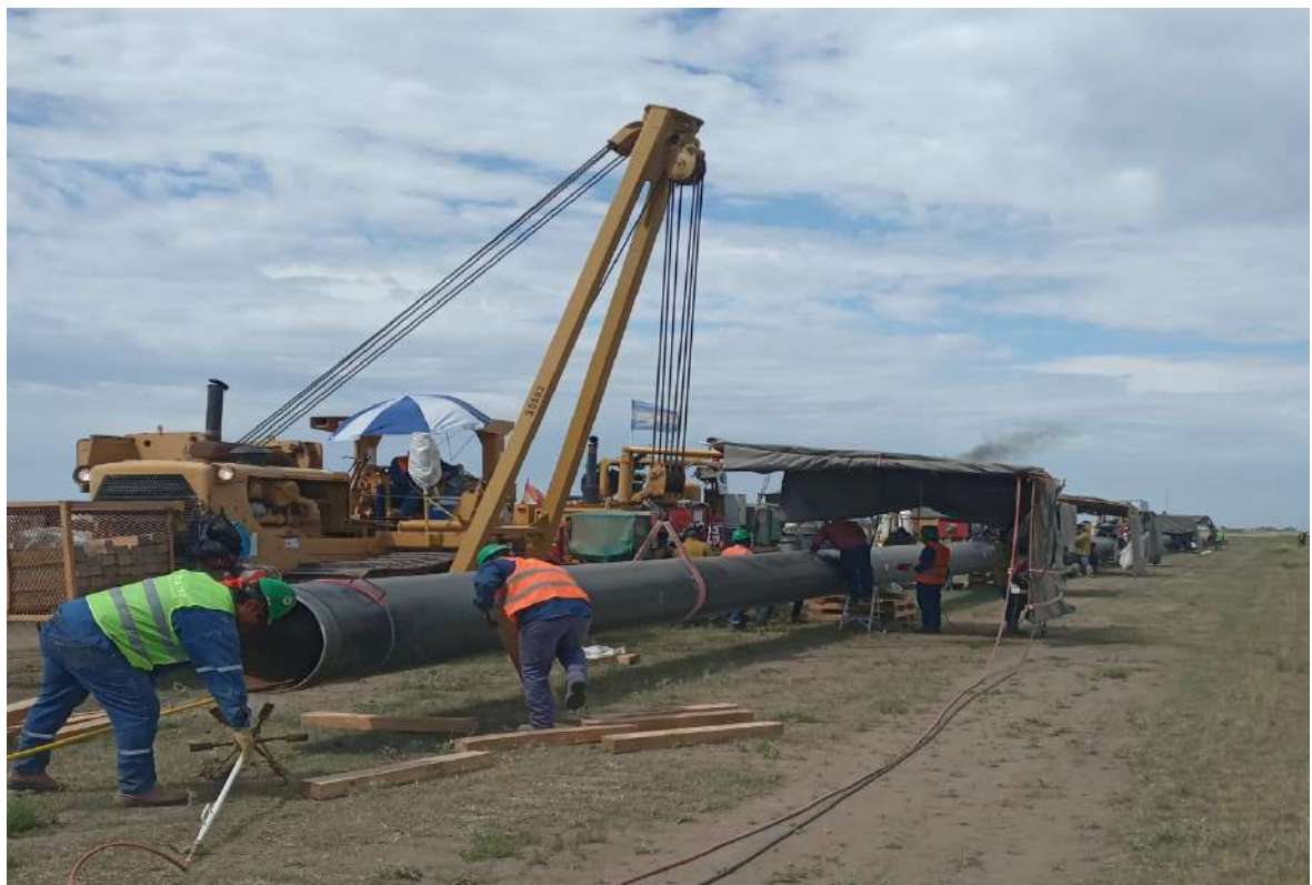
Soldadura en la Línea, de soporte o unión
