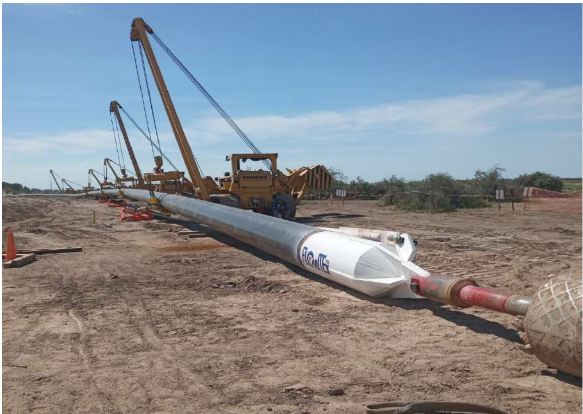
Teledirigido , Inserción de ducto columna de 800 mts. de largo.
