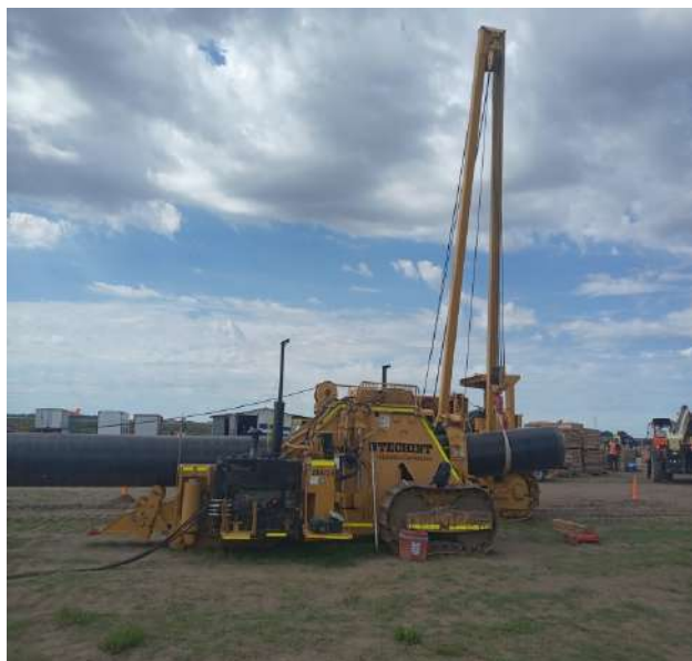
Sector de Curvado en el obrador
