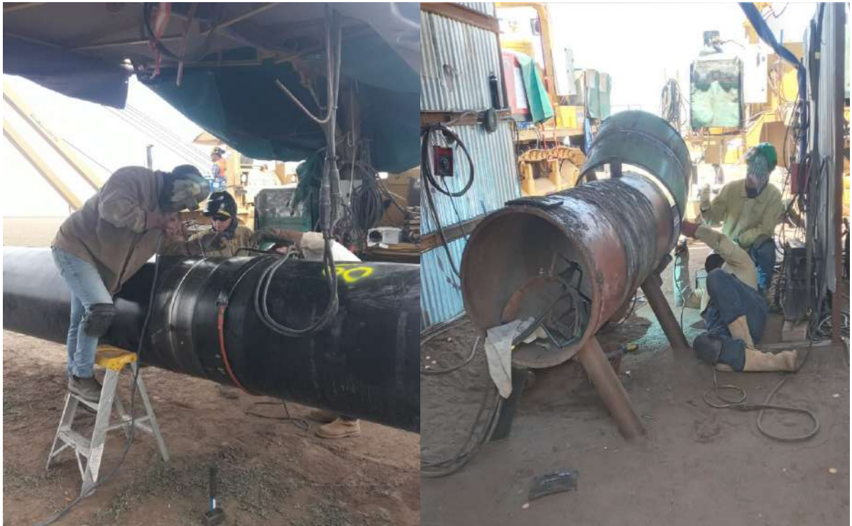
Soldador, Punteada en la Línea, Tareas en el obrador.
