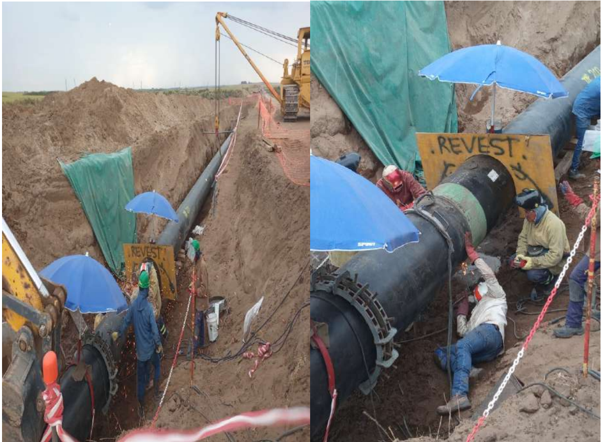
Empalme , PK 1+500 amolado, biselado y soldadura de tubo.
