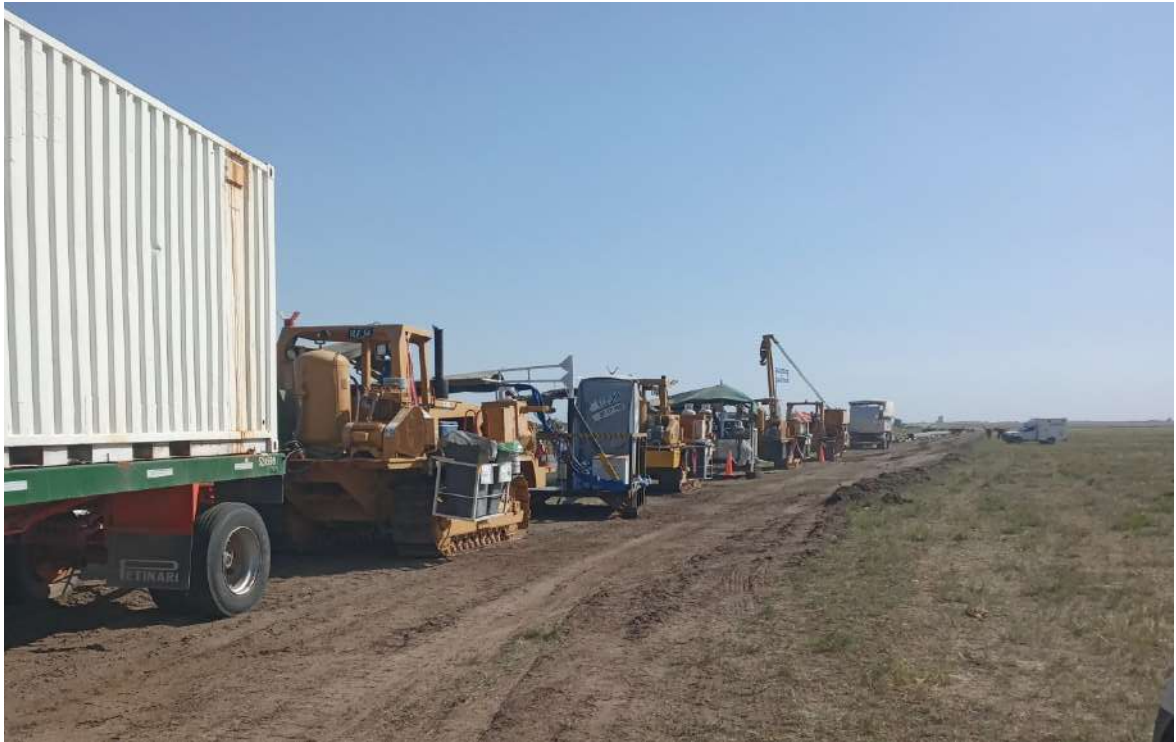
Soldadura en la Línea, conformación del tren de soldadura
