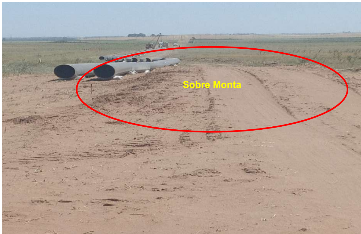
Apertura de Pista, Construcción de Sobre monta Zona Punta Alta
