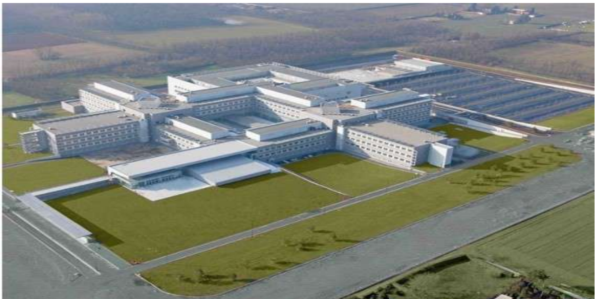
Italia – Obra Civil de Infraestructura y Arquitectura, Hospital Legnano
