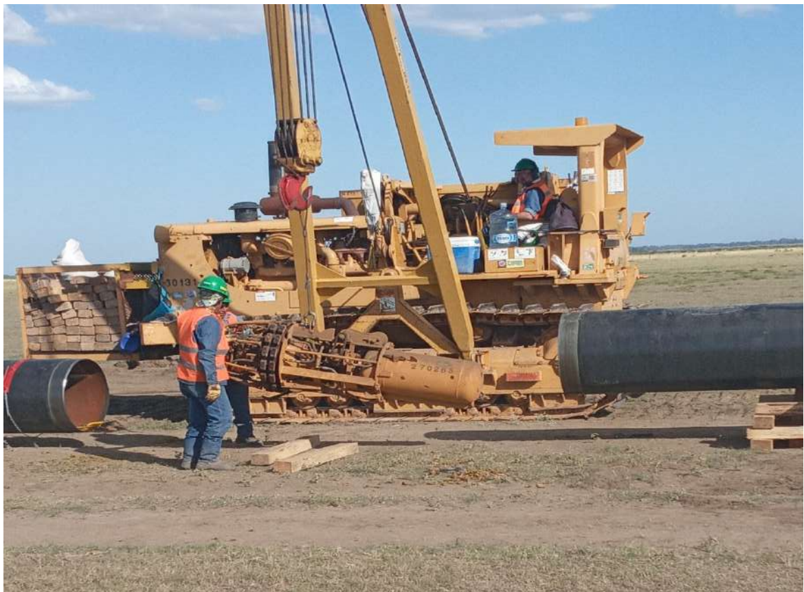
Acoplamiento, Tarea de Desacople y Mantenimiento Coronel Rosales
