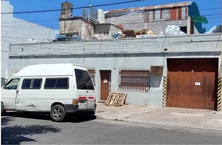
Foto 2 Ingreso de la empresa.
