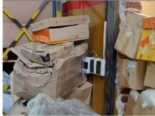
Foto 22 Tablero eléctrico y enchufes obstruidos.
