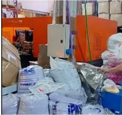
Foto 22 Tablero eléctrico y enchufes obstruidos.
