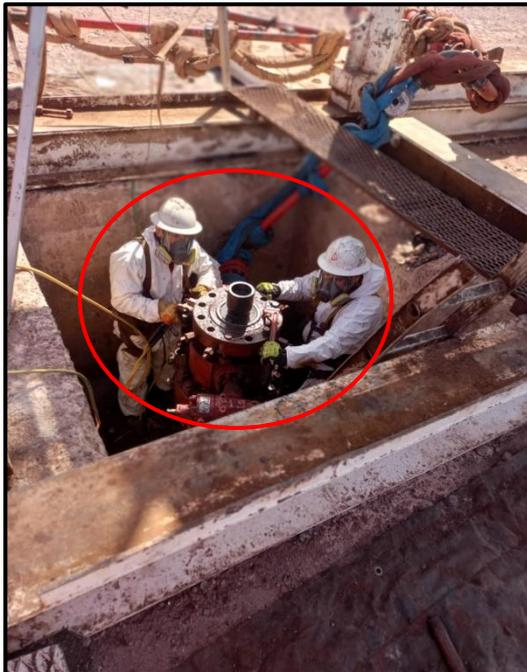
Se observa operarios utilizando mascara con filtros para gases y vapores inorgánicos. En el frente de trabajo no se evidencia detector multigas para monitorear la atmosfera, a su vez no se visualiza equipos autónomos de presión positiva para utilizar en caso de emergencia.
