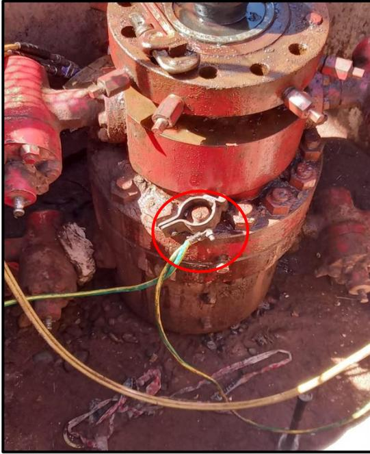
Se observa que puesta a tierra no se encuentra colocada correctamente y el cable en malas condiciones con revestimiento dañado.
