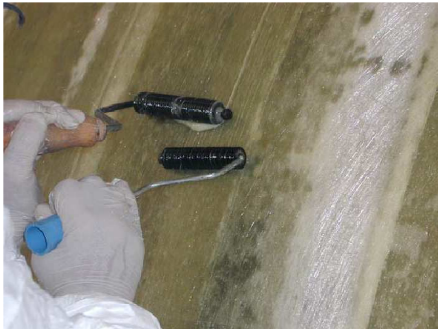
Figura 2.10 - Aplicación de barrera química con rodillo de desburbujeo
