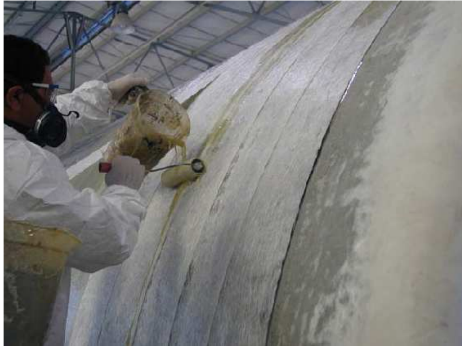
Figura 2.9 - Aplicación de barrera química con impregnación de fibra y resina
