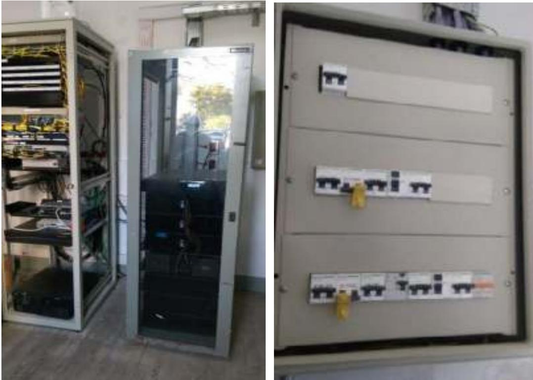
Vista del interior de un cuarto de comunicaciones presente en una estación (lado izquierdo), vista de un tablero principal (lado derecho), el mismo alimenta a el tablero seccional.
