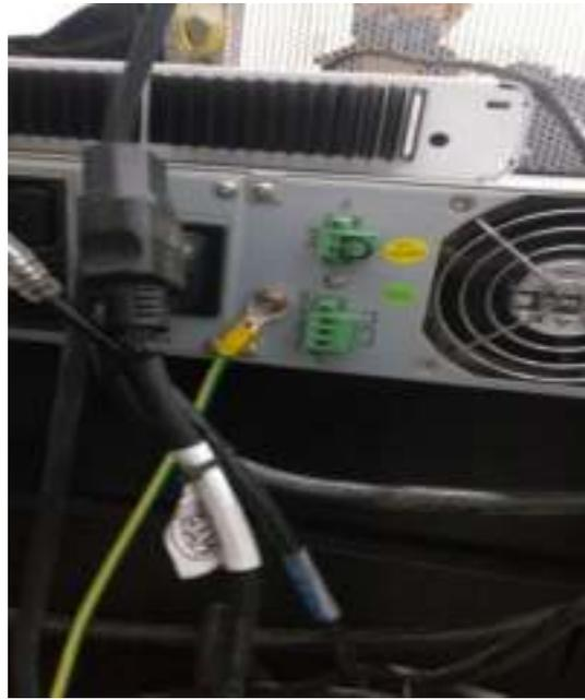
Conexión a masa de rack (lado izquierdo) y equipos (lado derecho)
