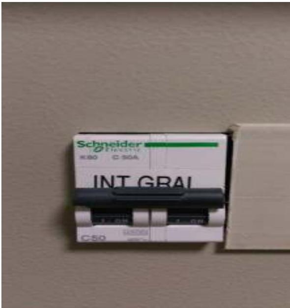
Imagen de llave térmica utiliza en tablero principal
