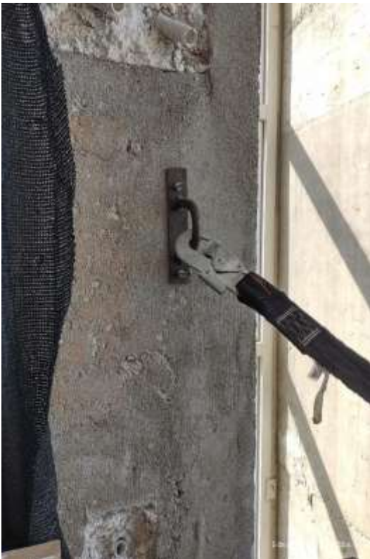
Deficiencia: falta de puntos de anclajes normalizados
