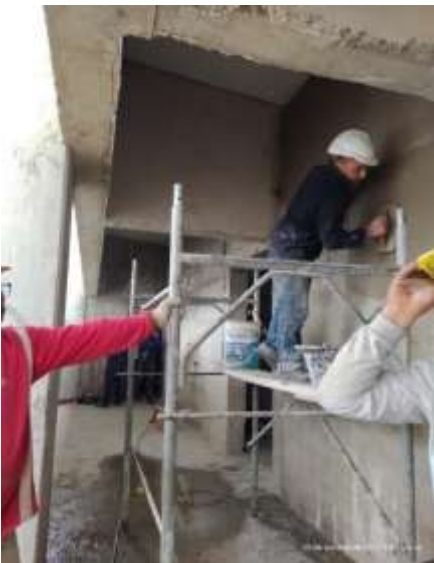
Plataforma de trabajo menor a 60cm de ancho mínimo.
