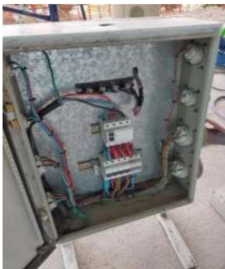
PAT conectado a cada toma corriente
