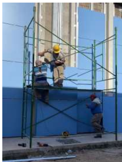
Plataforma de trabajo menor a 60cm de ancho mínimo.
