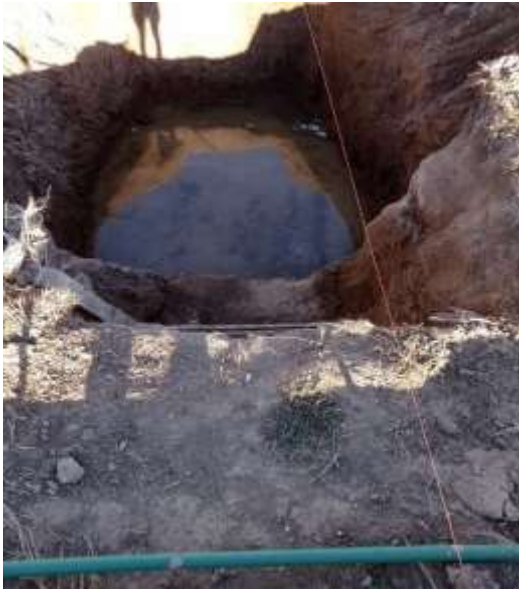
Desbarre de interior de zanja
