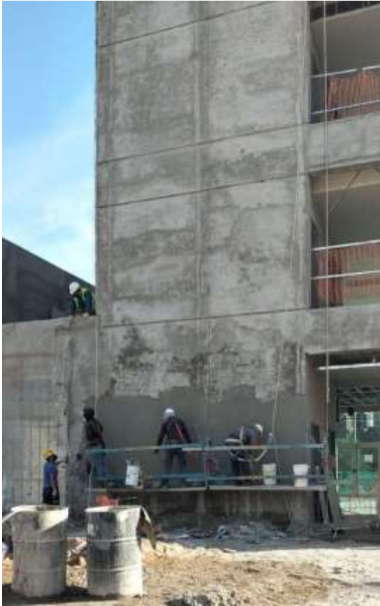
Uso de andamio balancín obra ISEP
