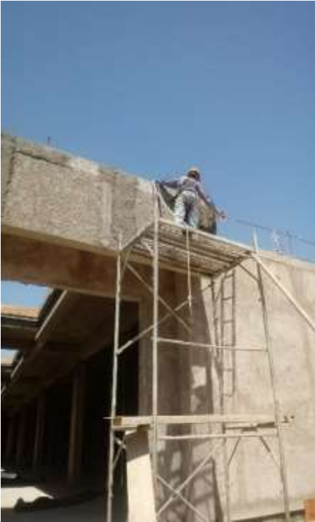
Barandas de contención contra la caída de personas incompleta.
