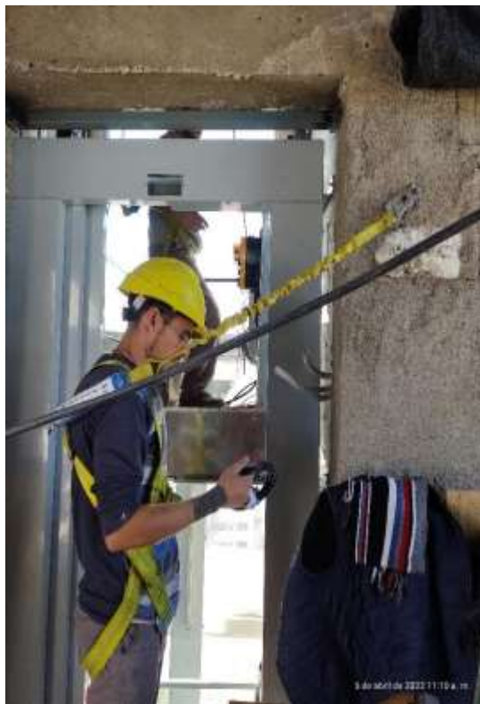
Mejora: puntos de anclajes fijos.
