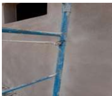
Deficiencia: largueros y travesaños improvisados y amarrado con elemento no adecuado
