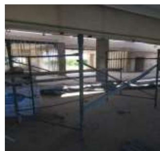
Deficiencia: largueros y travesaños improvisados y amarrado con elemento no adecuado
