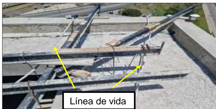
Líneas de vida amarradas a punto de anclaje diferente a las lanzas
