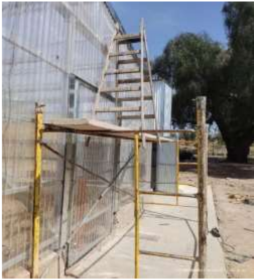
Extensión de andamio con escalera
