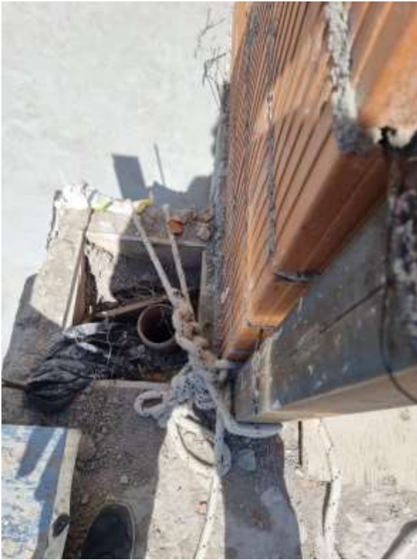
Deficiencia: falta de puntos de anclajes normalizados
