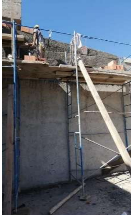
Barandas de contención contra la caída de personas incompleta.
