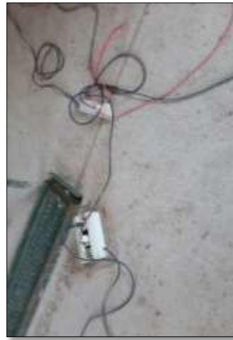
Prolongación sin doble aislación
