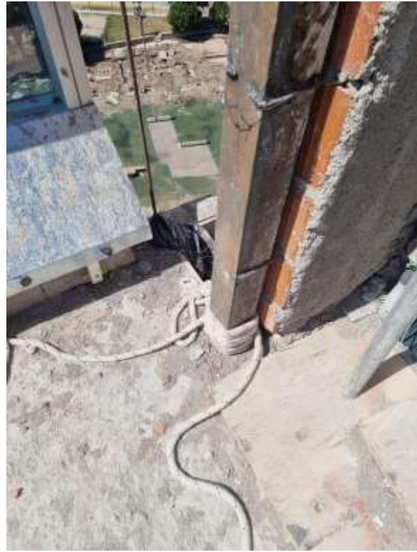
Deficiencia: falta de puntos de anclajes normalizados
