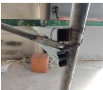
Deficiencia: largueros y travesaños improvisados y amarrado con elemento no adecuado
