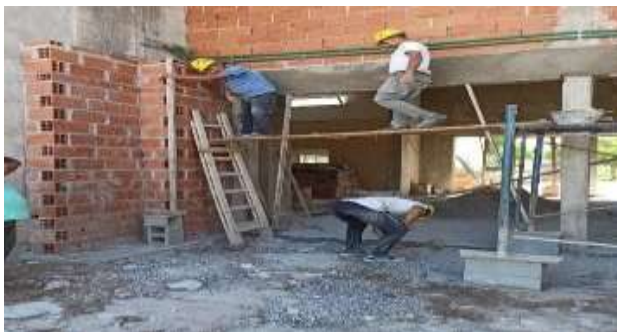
Deficiencia: montantes improvisadas.
