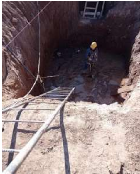
Desbarre de interior de zanja
