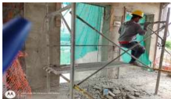
Deficiencia: montantes improvisadas.
