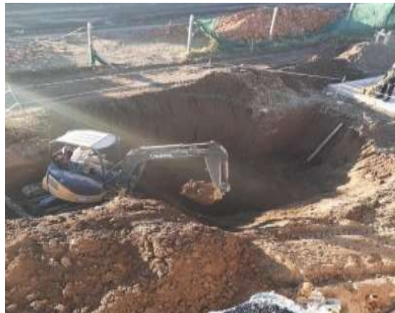
Excavación mecánica de cámara séptica
