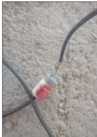
Prolongación sin doble aislación
