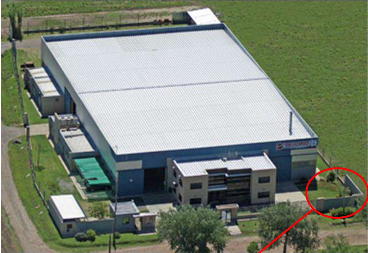
Figura 3.1 Ubicación de llave de corte de gas.
