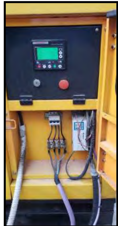
Motor de generador con recubrimiento de partes calientes y panel de control con sistema de detención de emergencia
