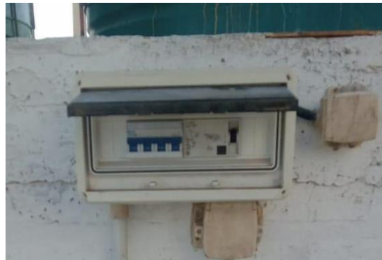
4 y 5. Tablero Piletas
