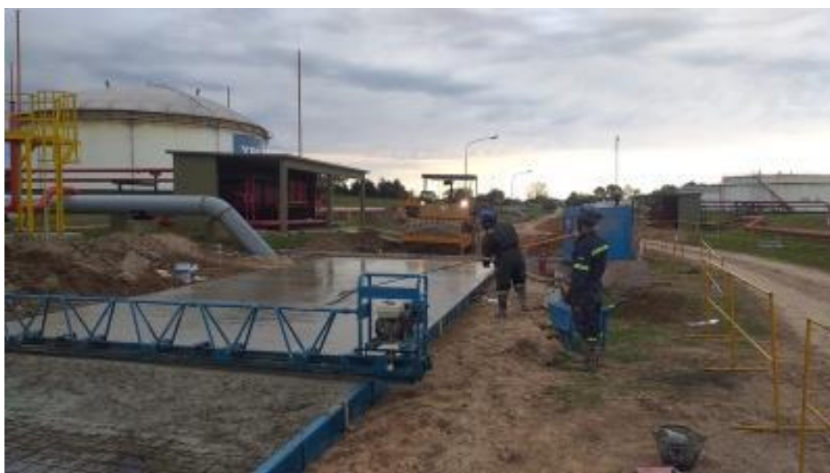
Figura 2.4 Empleados pasando el fratás mango largo
