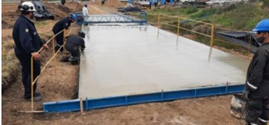
Figura 2.5 terminación de hormigón
