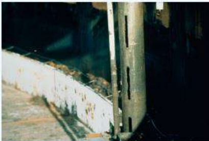
Figura 2.16: La medición por radar del modo de baja pérdida puede utilizarse para eliminar virtualmente la degradación de medición en tubos tranquilizadores antiguos.
