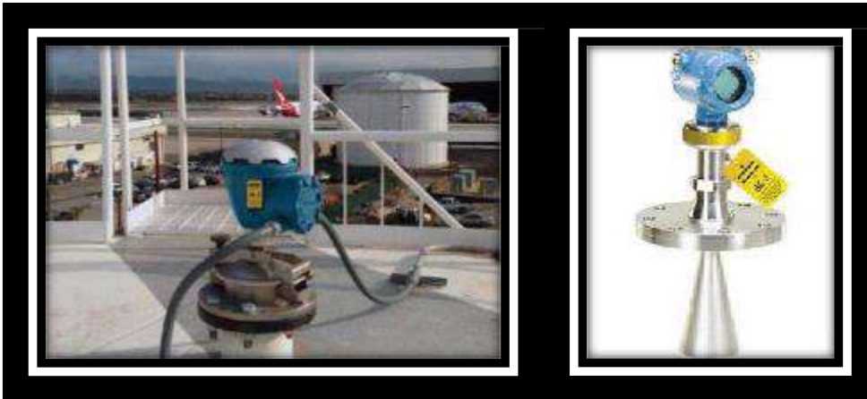
Medidor de nivel por radar moderno en un tanque de techo fijo / Transmisor de nivel por radar sin contacto
