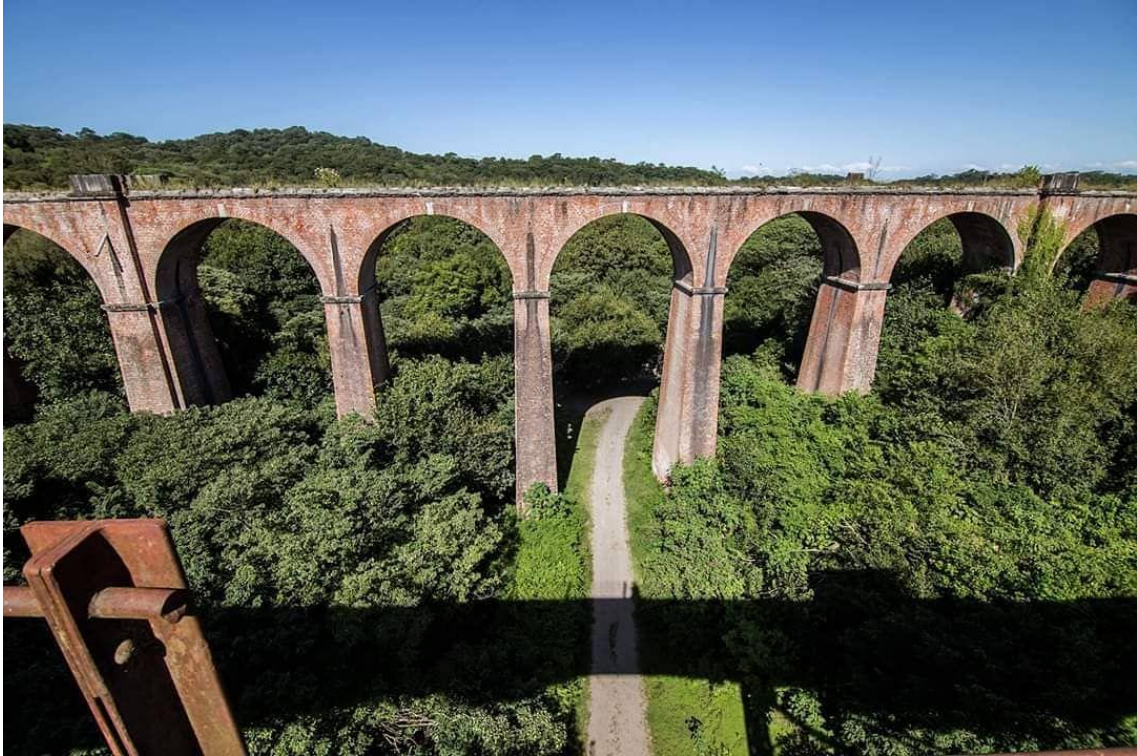
Imagen 26: Viaducto El Saladillo
