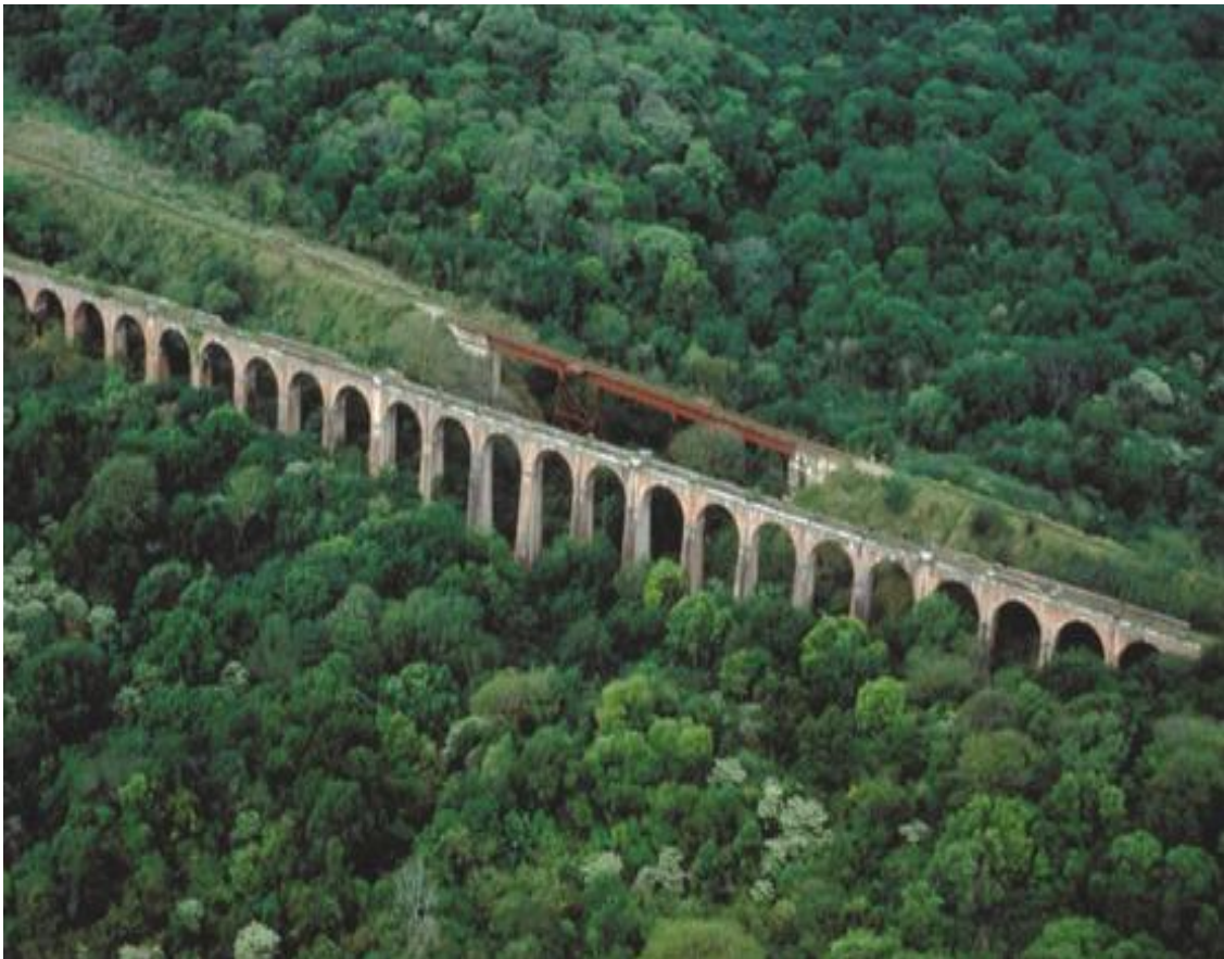
Imagen 27: Viaducto desde drone
