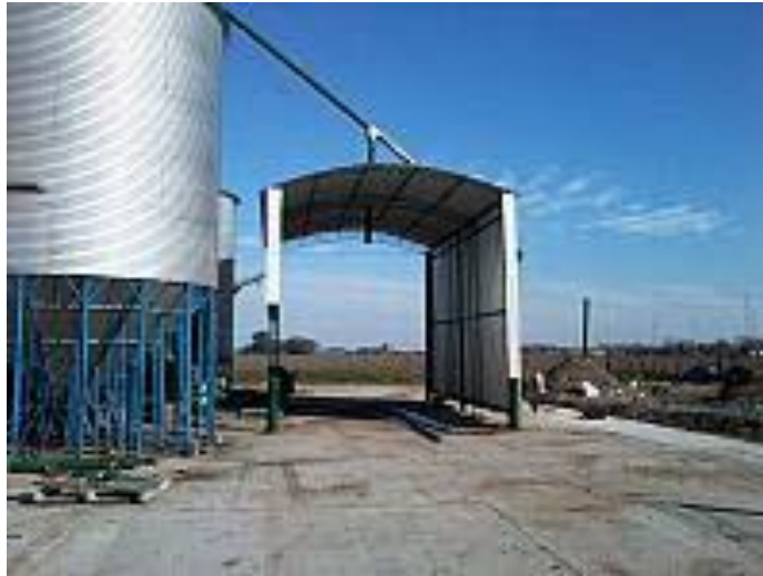
Figura 2.3 Área de descarga cubierta por los laterales Instalación para descarga bajo techo y con paredes laterales para reducción de la emisión de polvo y material particulado (MP)
