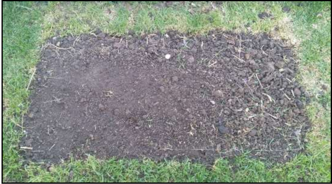
Imagen ilustrativa N°5: Se colocó la jaula de tejido hexagonal y por último se procedió a cubrir completamente con tierra.
