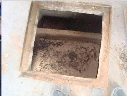
Foto: Limpieza de cámara mediante aplicación de turba vegetal.
