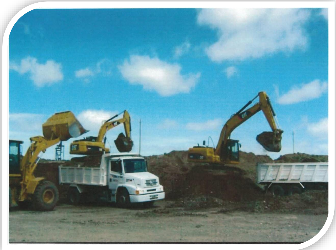
Foto N° 5: Disposición Final de Suelo tratado mediante Biorremediación.
