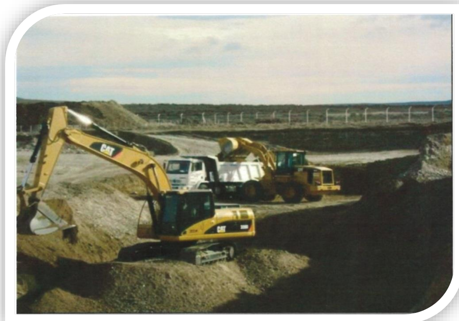
Foto N° 2: Acopio de Material, Carga y Transporte para armado de Biopilas en Repositorio.
