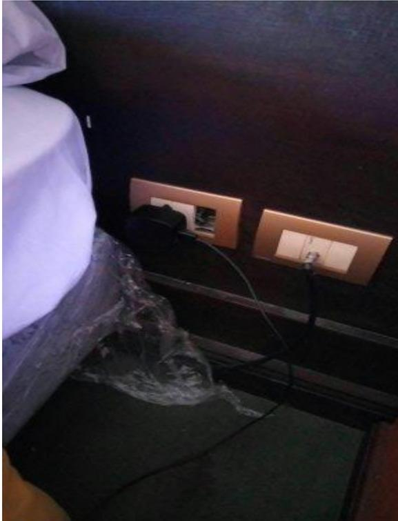
En esta fotografía se puede evidenciar como está colocado el enchufe. Le falta una parte al tomacorriente y, sin embargo se colocan artefactos.
