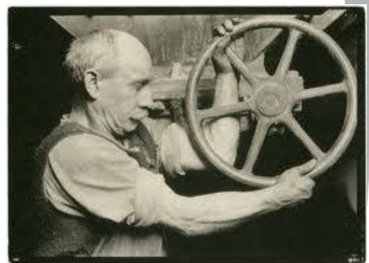
fig. 1.1: Trabajador utilizando fuerza excesiva
