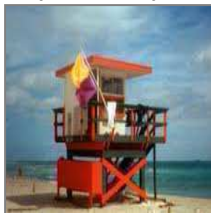
Imagen 4: Casilla de vigilancia
