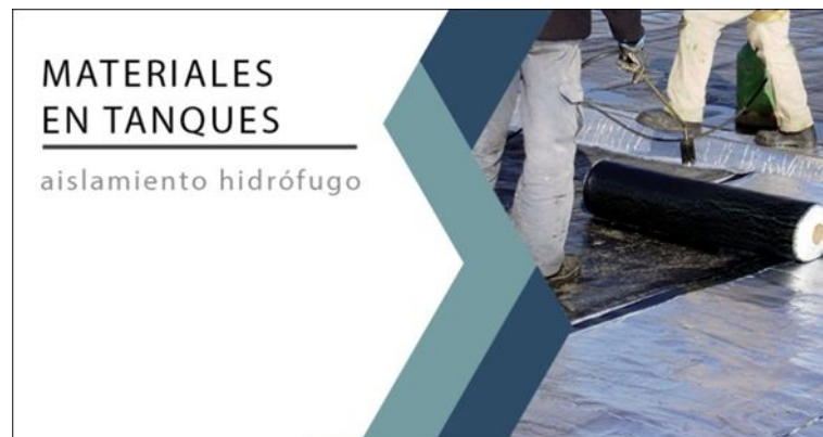
Figura N°6 Materiales en tanques
