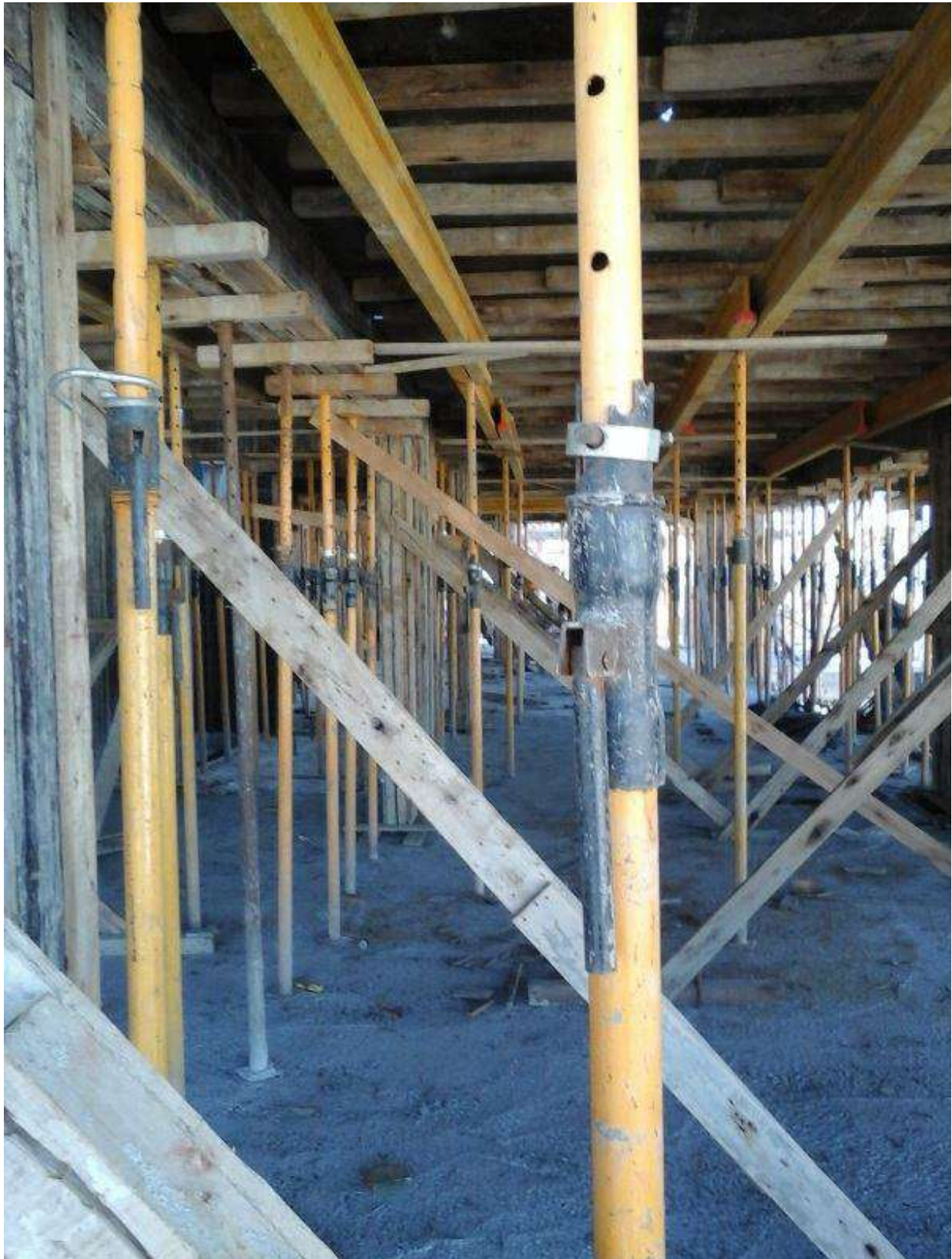
Apuntalamiento de losa
