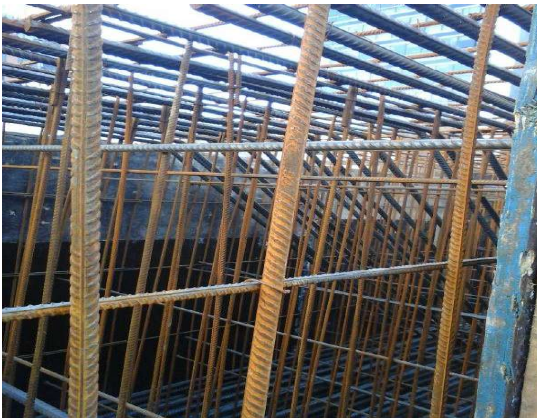
Armaduras de acero
