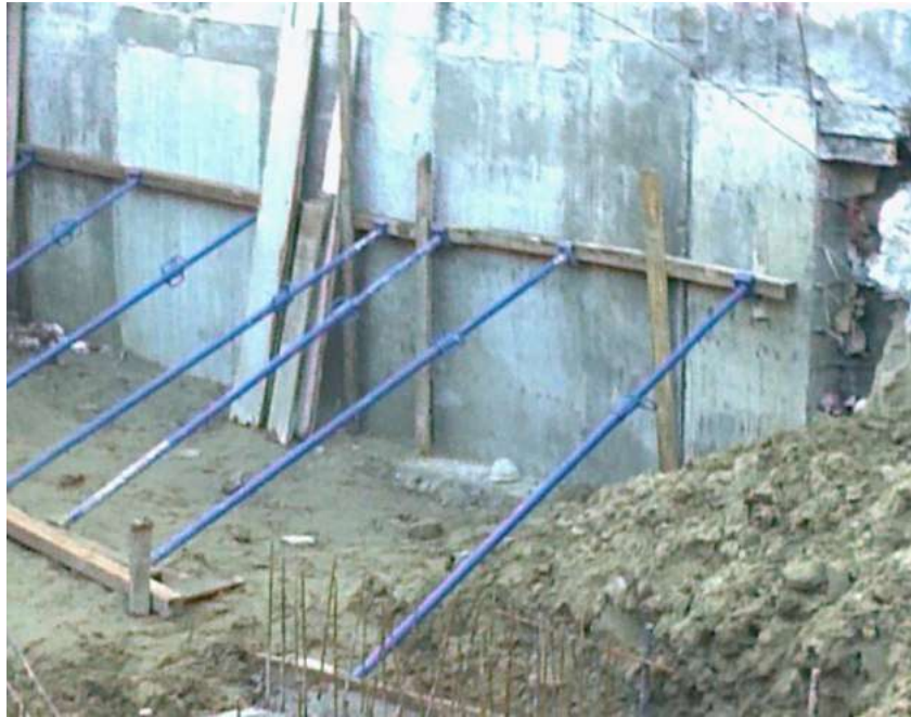
Apuntalamiento de submuración.
