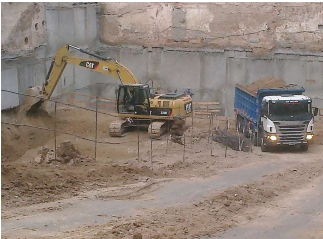
Excavación con retiro de tierra.
