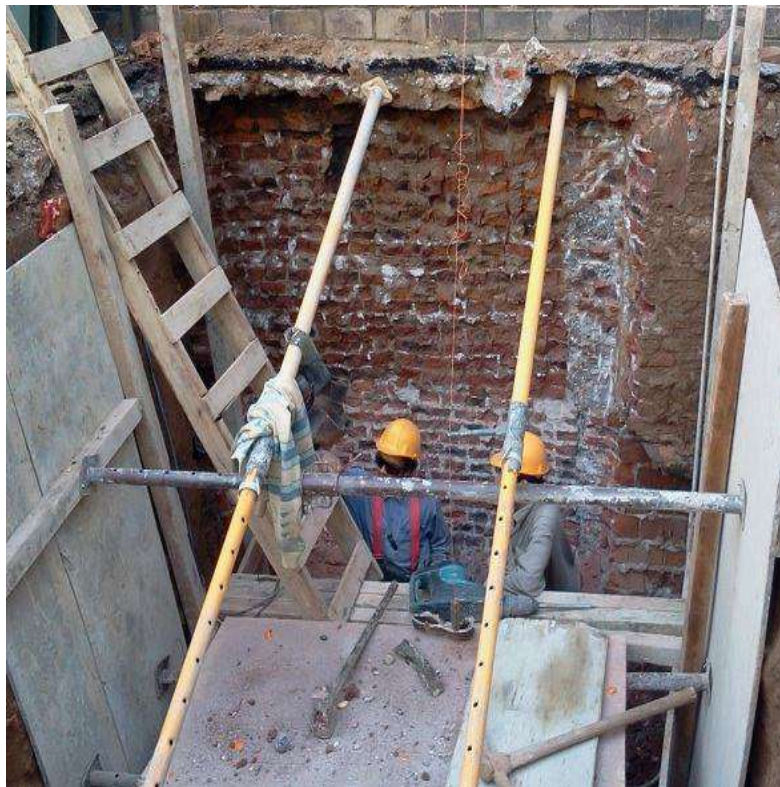
Apuntalamiento de excavación.
