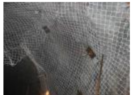
Sostenimiento con perno elicoidal y malla romboidal
