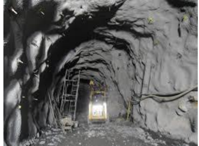
Lanzado de Schocrette en paredes de labor minera
