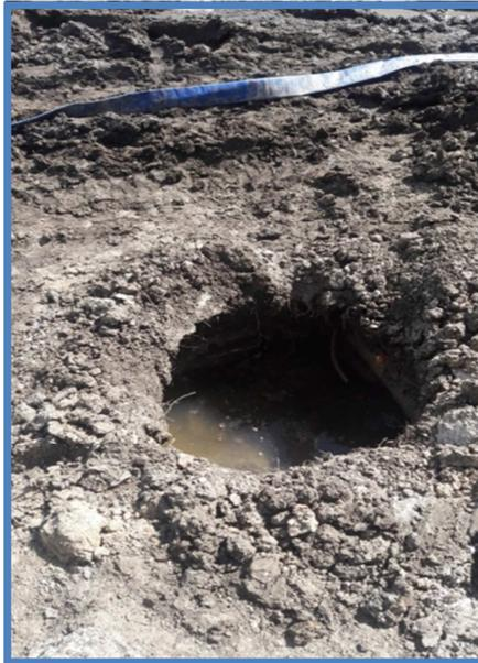
En la imagen 1.1.1 se puede observar el inicio de una excavación manual. También se puede ver la cantidad de agua que brota de las napas, que luego se explicara cómo se retiraba.
