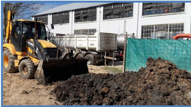
En esta imagen se ilustran las maniobras para retiro de tierra usando retro excavadora y camión batea.
