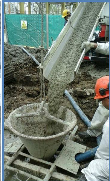
La figura 1.1.4 muestra la maniobra de izaje y colocación de armadura. Las imágenes 1.1.5 y 1.1.6 ilustran el llenado del pilote con hormigón.
