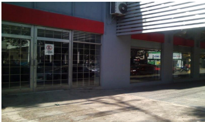
FOTO 1.6 GARAGE DE DESCARGA
